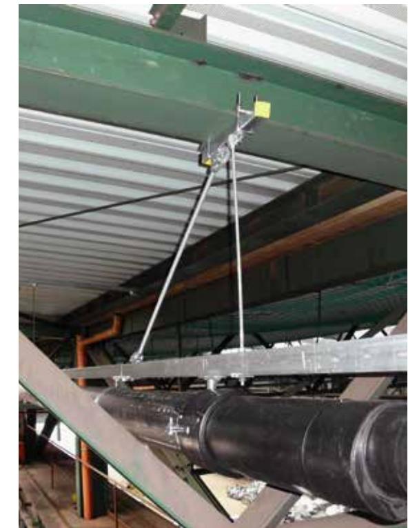
Nach der Sanierungsmaßnahme
