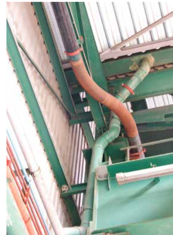
Vor der Sanierungsmaßnahme
