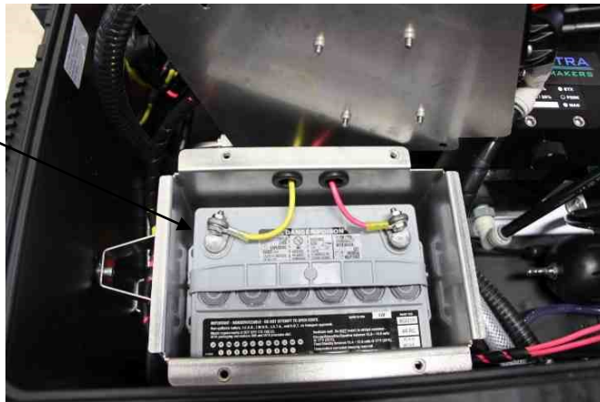
EL-BAT-AQB AQUIFER BATTERIE
