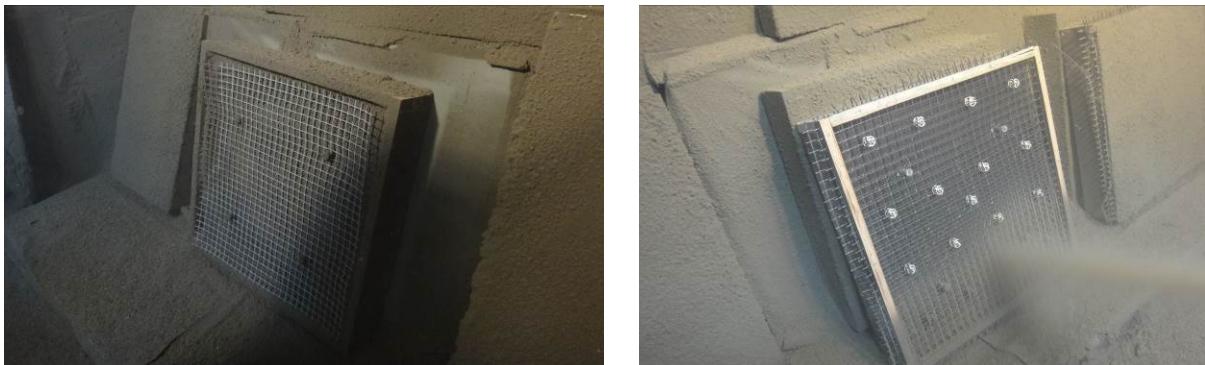
Bild 11: Herstellung mit Ankern; links: Laminierverfahren; rechts: ein Spritzvorgang
