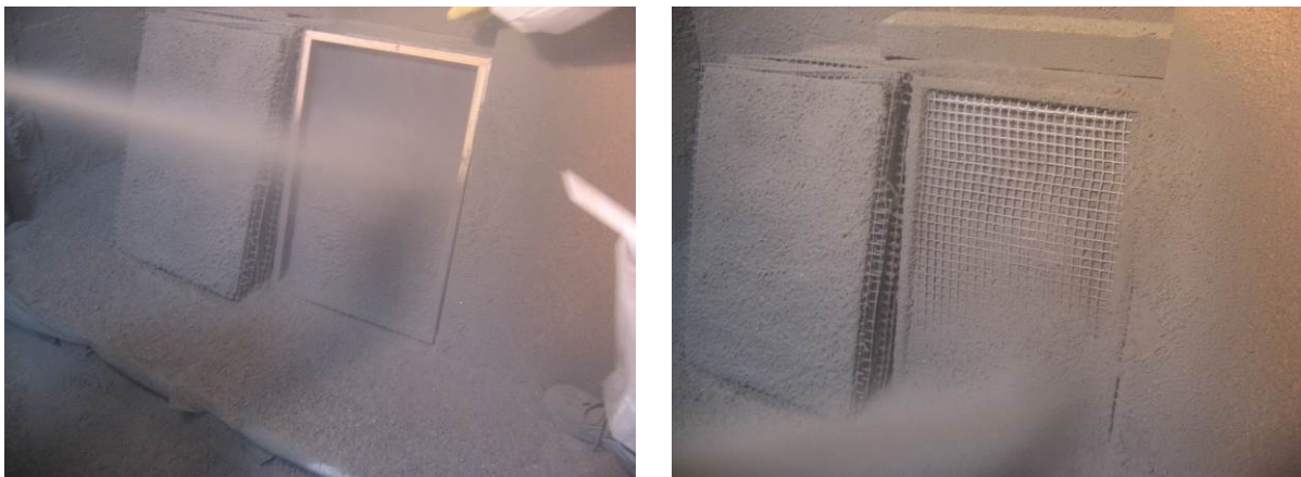
Bild 8: Herstellprozess im Laminierspritzverfahren; Spritzen der ersten Schicht, Einlegen der ersten Textillage und Spritzen der mittleren Schicht, Einlegen der zweiten Textillage und Herstellung der letzten Schicht
