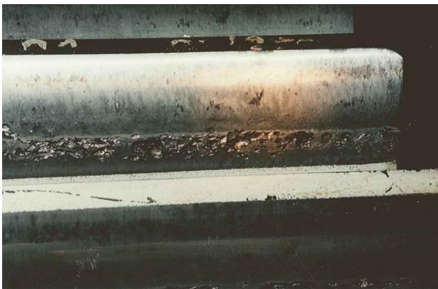
Abbildung 4: Abplatzer, großflächiger als Pitting 22
