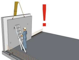
Abhängen der Krankette nach Befestigung der Schrägstützen
