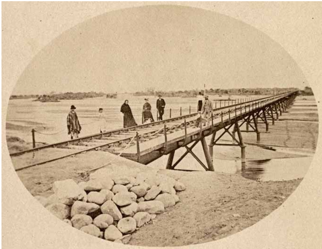
Abb. 110: Die Eisenbahnbrücke über den Rio Primero bei Cordoba (Fotografie, 1876) Quelle: Archiv für Geographie, SAm078-0017
