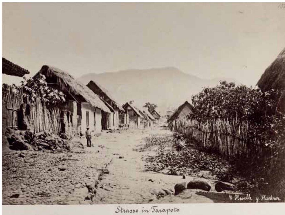
Strasse in Tarapoto Abb. 96: Straße in Tarapoto (Fotografie von Kroehle y Huebner, ca. 1875) Quelle: Archiv für Geographie, SAM096-0011
