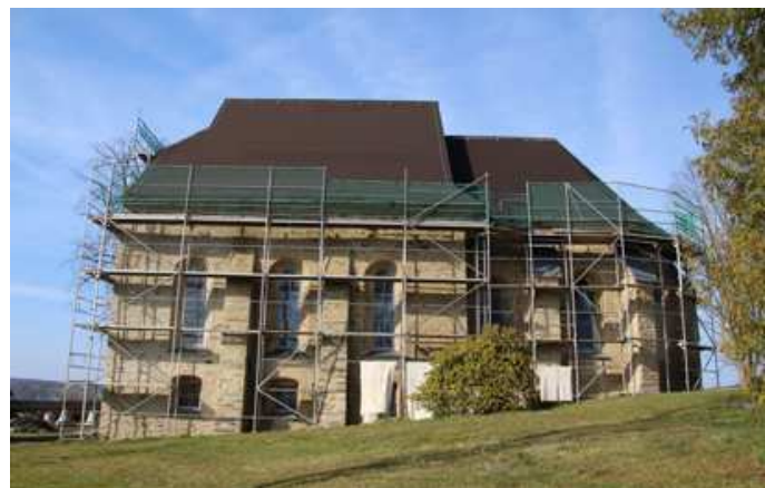
Wehrkirche in Sanierung
