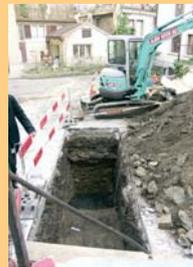
Eine mit dem Kleinbagger durchgeführte Sondierung gibt Aufschlüsse über die Schichtverhältnisse.
