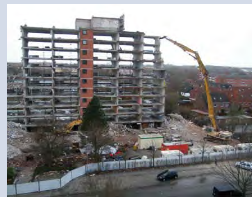
Glaspalast vor und während des Abrisses Fotos: Stadt Emden
