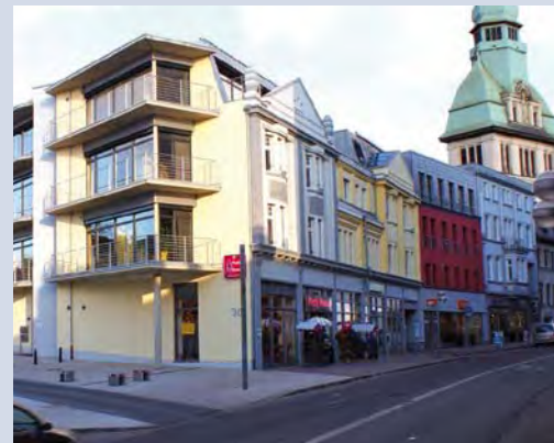
Vor und nach der Sanierung Fotos: Stadt Völklingen
