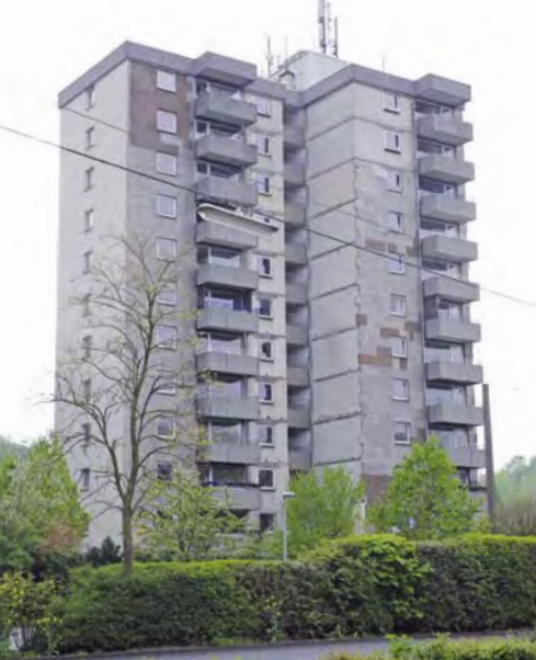
Teilweise geräumtes Wohnhaus
