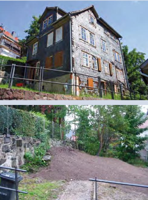
Wohngebäude vor dem Abriss (oben) und geräumte Fläche nach Abriss Foto: Stadt Ruhla
