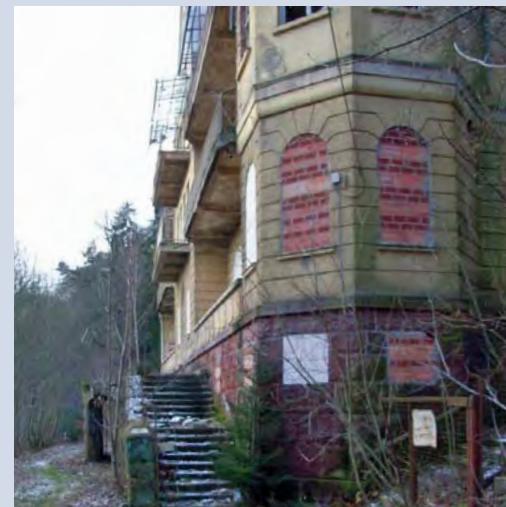
Vor und nach der Zumauerung des Obergeschosses Fotos: Stadt Bad Berka
