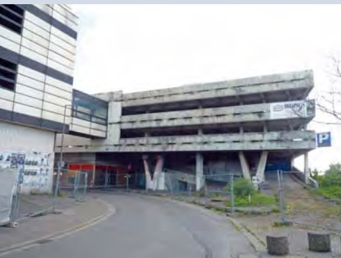
Ehemaliges Kaufhof-Parkhaus Fotos: Stadt Völklingen
