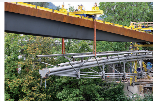
Ausfahren der Bestandsbrücke am neuen Tragwerk
