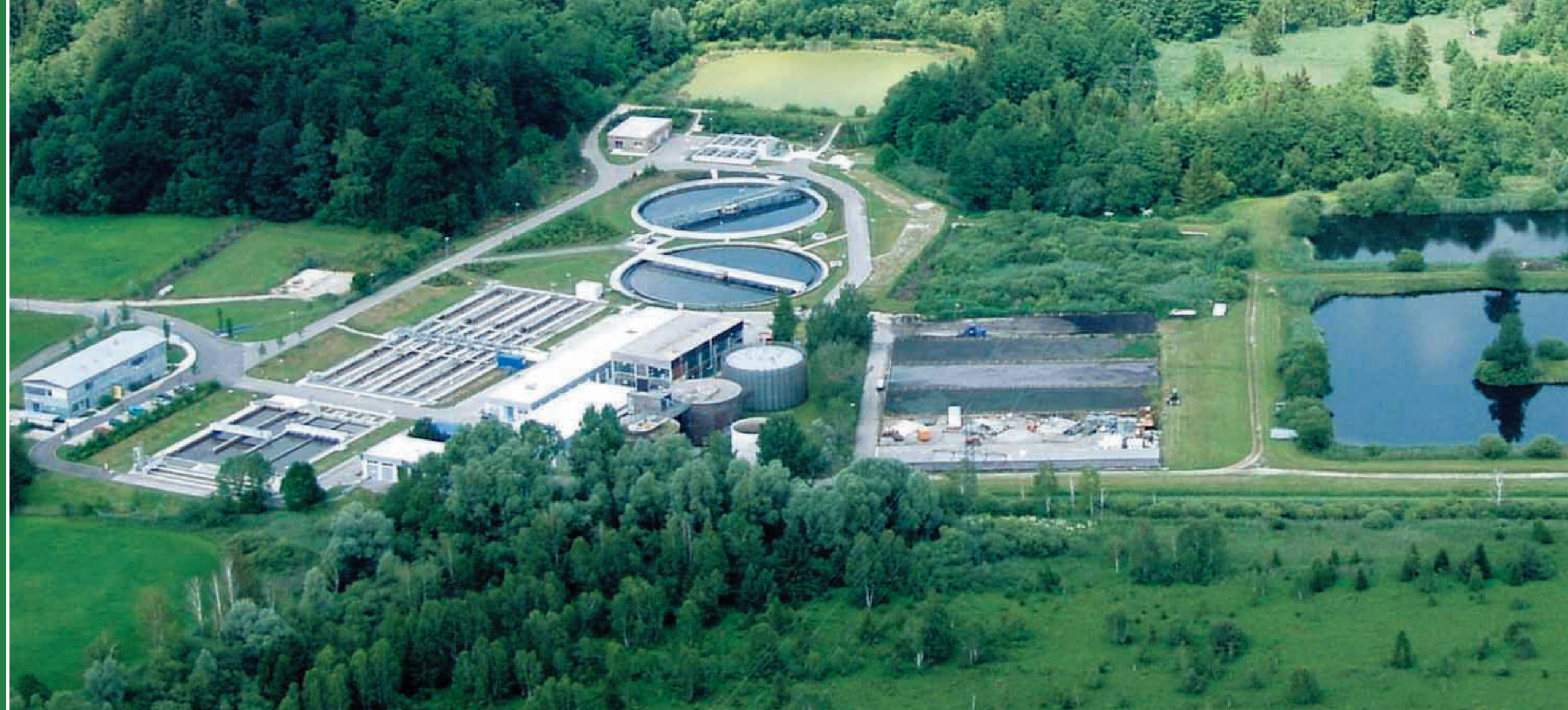
Klärbecken aus der Luft, Foto: Abwasserverband Starnberger See
