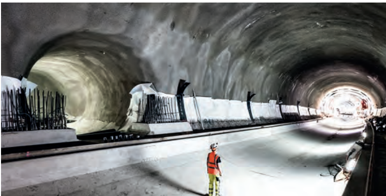
Außenschale und Sohlgewölbe mit Zugang Rettungsstollen
