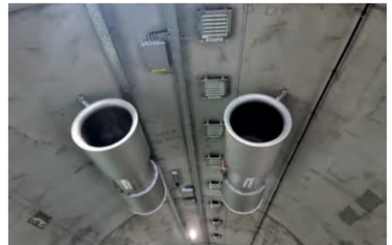
Strahlventilatoren
