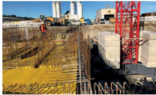
Bewehrungsarbeiten Decke Untergeschoss
