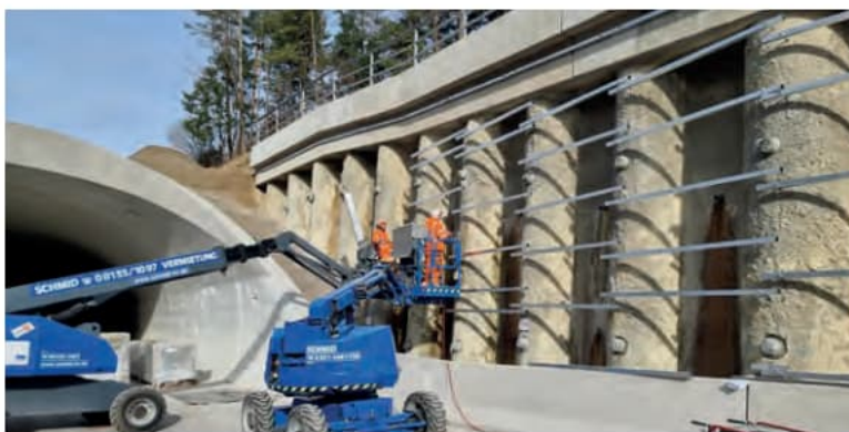
Montage Lärmschutzelemente auf Bohrpfehlwand
