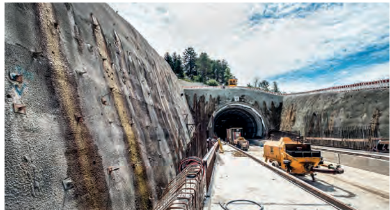
Spritzbetonsicherung im Vorfeld Nord
