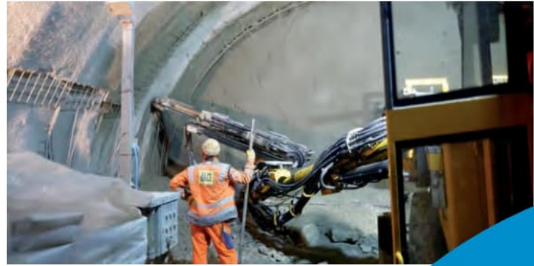
Radialer Ankereinbau Sicherung von Gebirgs auflockerungen hinter der Außenschale
