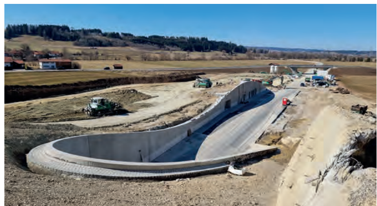
Hinterfüllung Portal Nord und Betriebsgebäude
