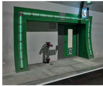
Zugang zum Rettungsstollen
