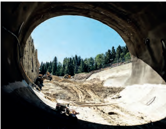
Erdarbeiten im Vorfeld Süd
