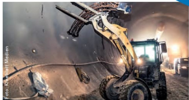
Herstellung der Außenschale Bewehrungseinbau Spritzbetoneinbau
