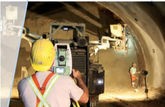
Herstellung der Außenschale Bewehrungseinbau Spritzbetoneinbau
