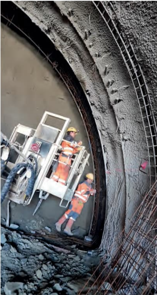
Radialer Ankereinbau Sicherung von Gebirgs auflockerungen hinter der Außenschale
