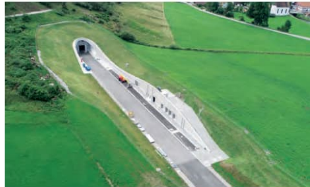
Betriebsgebäude von oben
