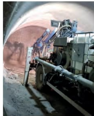
Herstellung der Außenschale Bewehrungseinbau Spritzbetoneinbau
