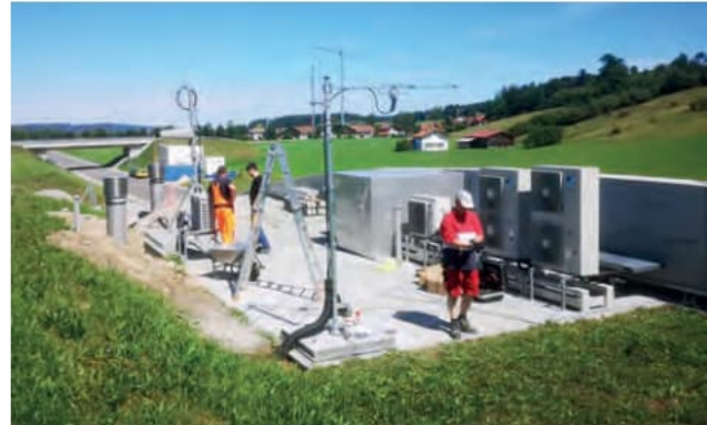
Montage von Antennen auf dem Betriebsgebäude
