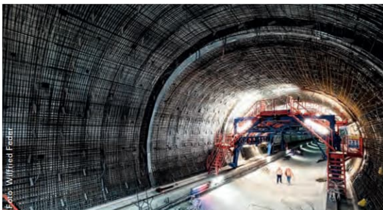
Bewehrungsarbeiten Gewölbe
