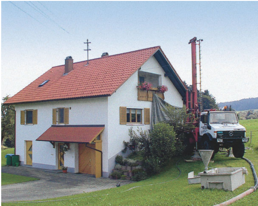
Bohrarbeiten für eine Erdwärmesonde an einem Einfamilienhaus.
