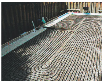
Wärmetauschersystem in einer Energiebodenplatte.
