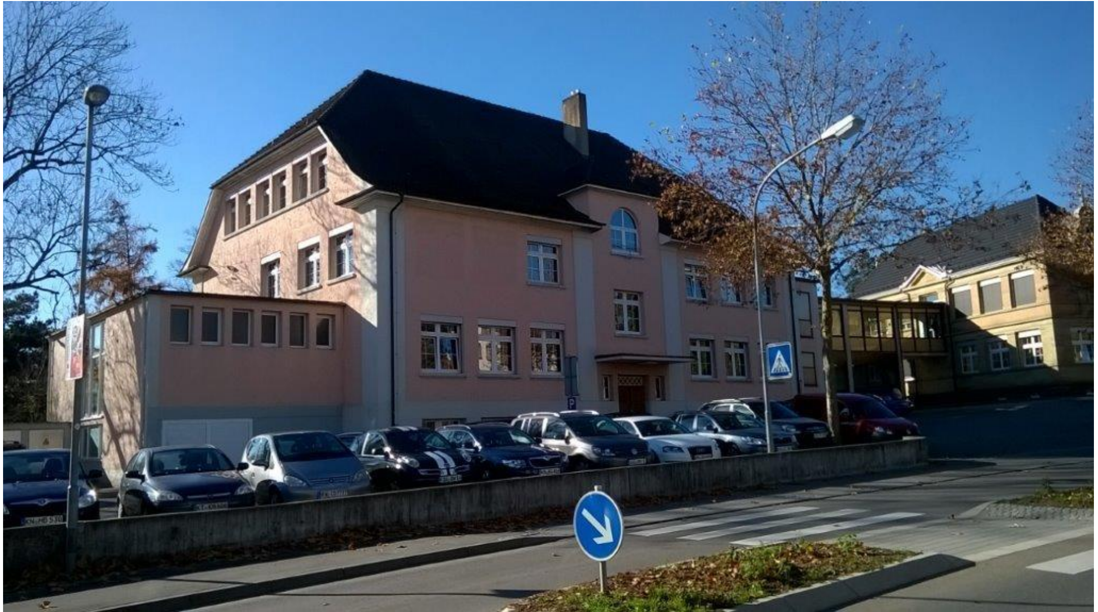
Haus 2 vor der Sanierung, die dieses Jahr begonnen hat
