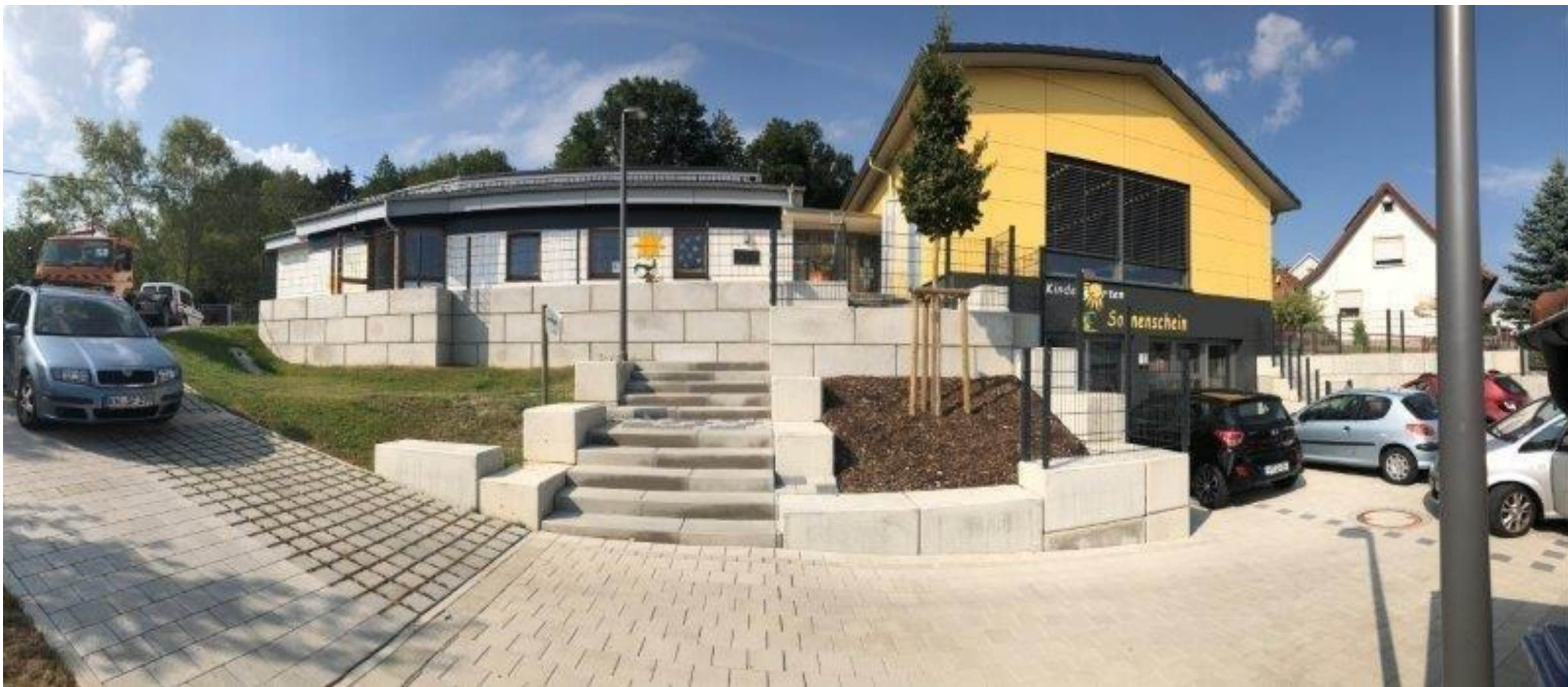
Kindergarten Sonnenschein in Zizenhausen – 2017 saniert und Neubau erstellt
