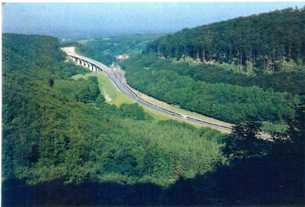
Bild 1: Blick auf die Neubaustrecke der B 1 Umgehung Kohlstädt vom Rabensknapp in Richtung Westen.
