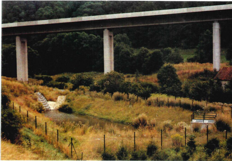
Bild 3: Regenrückhaltebecken im Strothetal zur Vorklärung des Oberflächenwassers der B 1 und Strothetalbrücke
