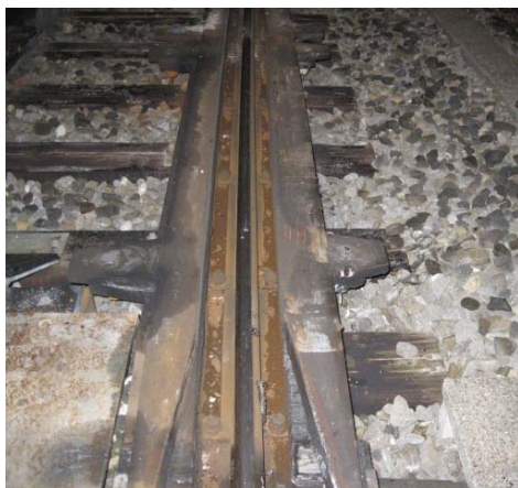
Foto 2: Schäden an der Gleisbremse
