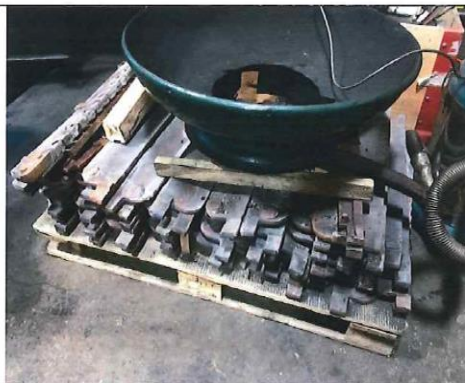
Bild 8 Ausgebauter Planrost
