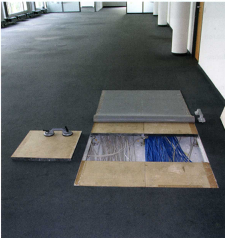
Links Die zentrale Trassenführung in einer Hohlbodenfläche: Zugänglich über eine geöffnete Doppelboden-trasse.
