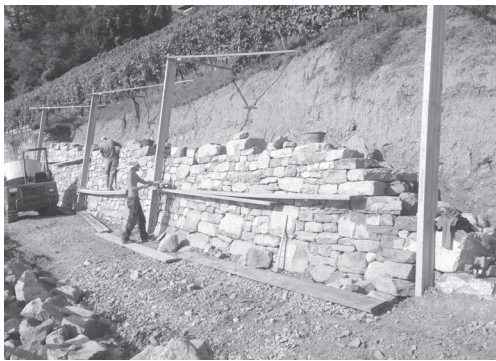
Abb. 34 + 35 Bau einer Trockenmauer (Quelle: Reto Ingold)
