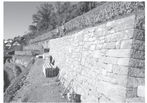
Abb. 30 - 33 Arbeitsschritte beim Bau einer Trockenmauer (Quelle: Trockenmauer - Anleitung für den Bau und die Reparatur)
