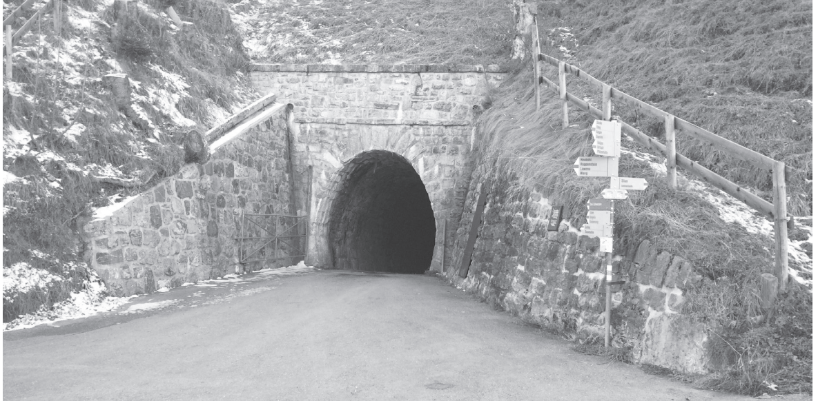
Abb. 59 Flügelmauern beim Tunneleingang Malbun in Liechtenstein (Bild: Peter Vogt)
