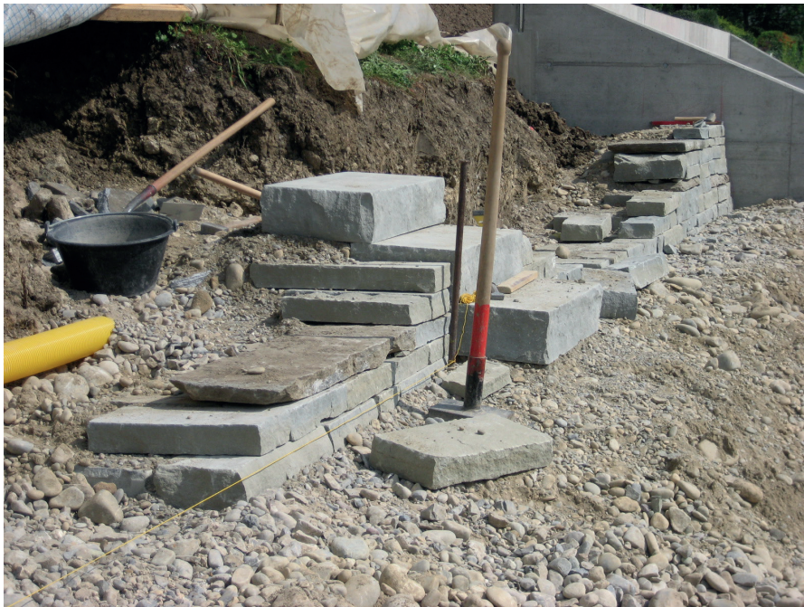
Abb. 1 Sandsteinmauer mit labilem Fundament; Gartenbau K. Köchli, Bild: B. Schächli
