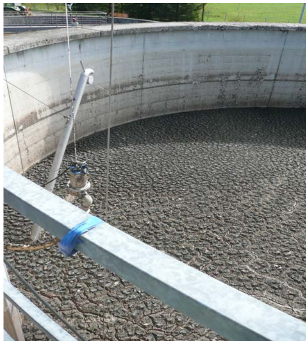
Abbildung 4: Schlammstapelbehälter mit dichter Schwimmdecke
