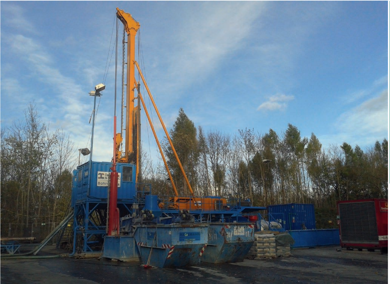
Bohrplatz REMLINGEN 15 der Asse GmbH
