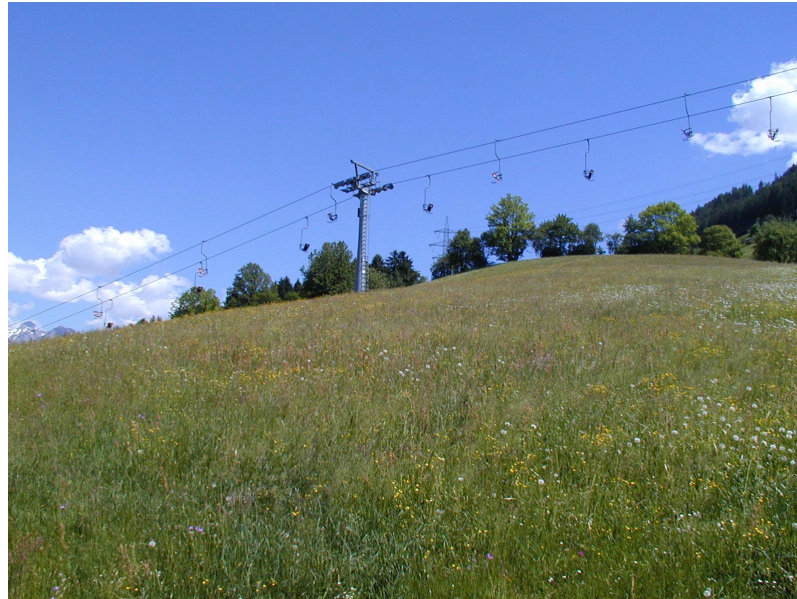
Abbildung 2.8: Temperaturprofil Schwaz: Standort des Sensors auf 767 m ü.M.: Stütze 9 der Kellerjochbahn
