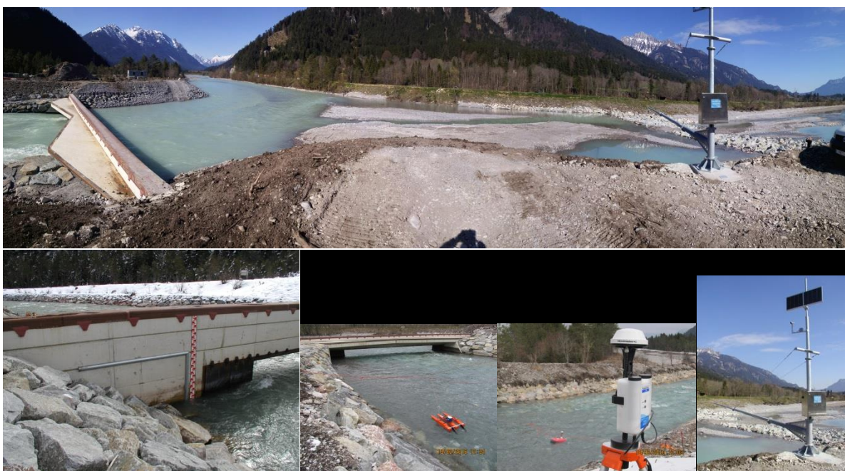
Fotos: Land Tirol; oben: Panoramabild des Lech im Bereich der Geschiebefalle unten von links nach rechts: Drosselbauwerk, Kalibrierfahrt (Drosseldurchfluss) mittels ADCP, GPS Station, Messmast für die Wasserstandsmessung im Einlauf zur Geschiebefalle mit Geräteträger, Solar-Stromversorgung und Videokamera
