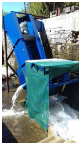
Abbildung 3: Installation der textilen Schaufeln
