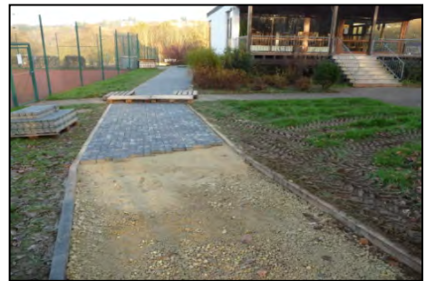
Wegebau Clubhaus, November 2014
