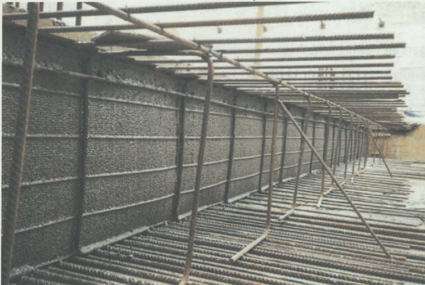
Bild 2: Abschalelement nach Betonage 1. Abschnitt
