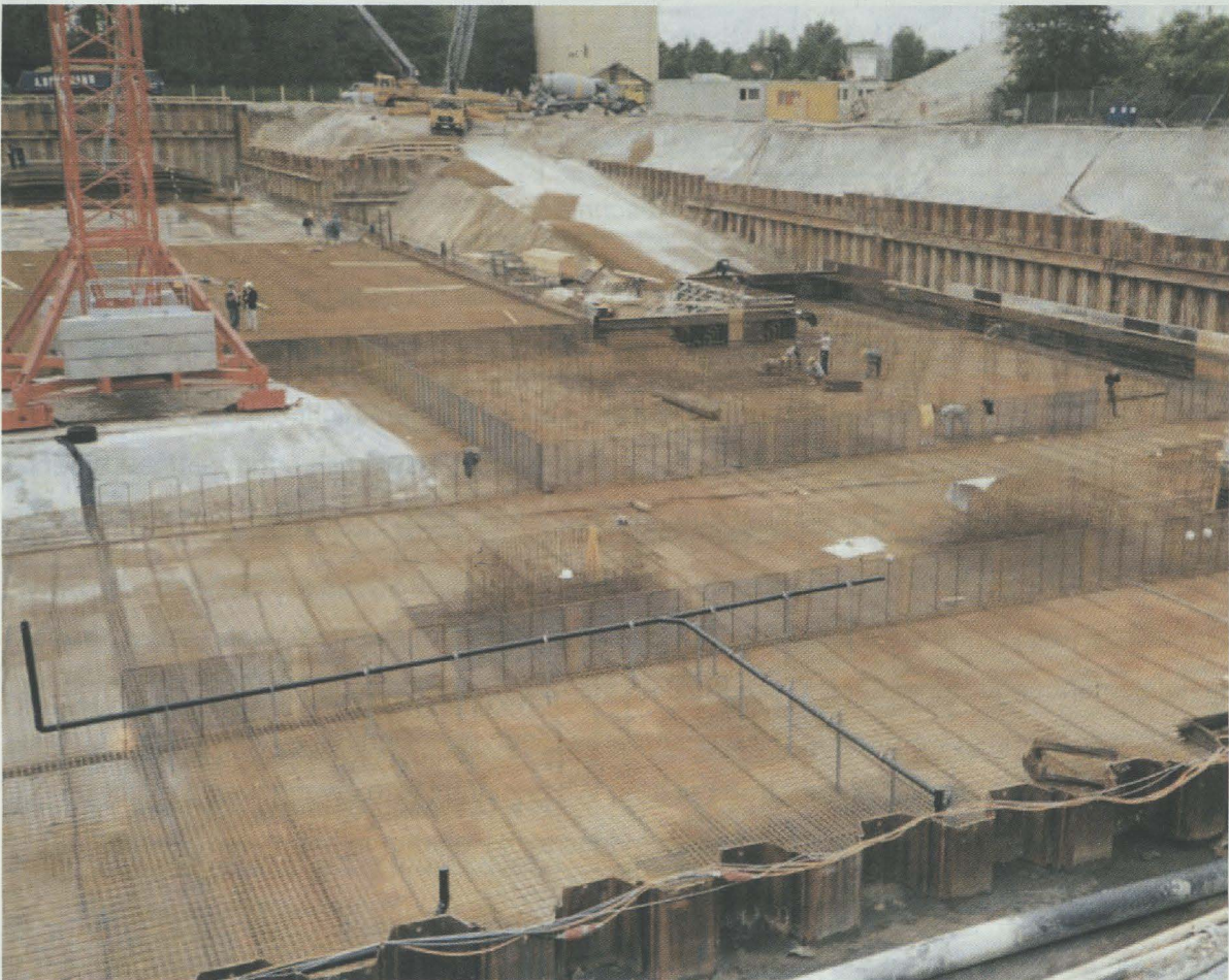
Bild 1: Begrenzung der Betonierabschnitte mit STREMAFORM-Abschalelementen
