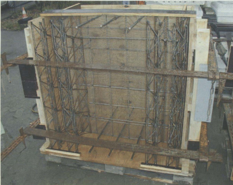
Bild 5: Schalung mit STREMAFORM-Abschalelement
