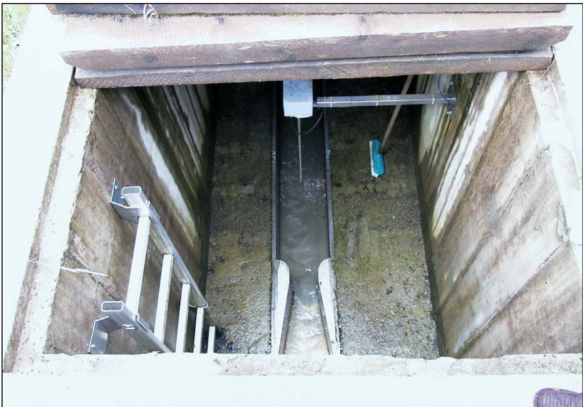
Abbildung 4–12: Ablaufmessschacht
