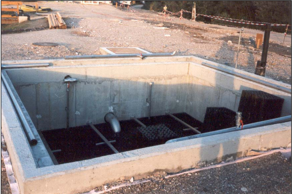
Abbildung 4–9: Nitrifikationsbecken
