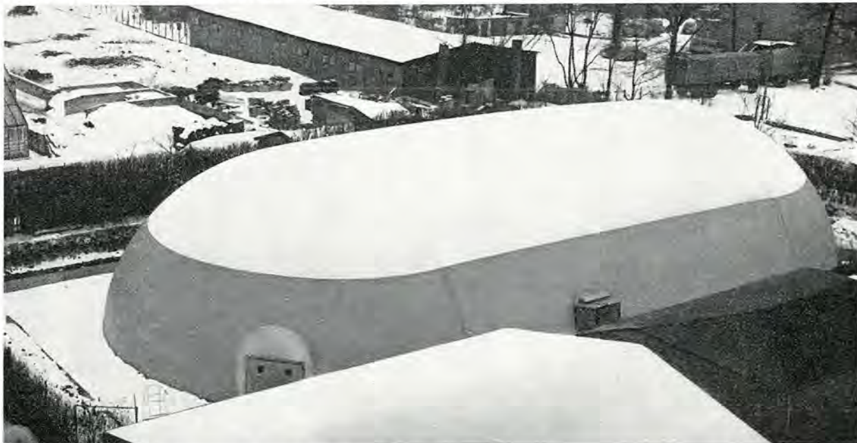
KLEYER-aeroform Tennishalle 35x18x7 m, vom Berliner Tennisverband beim Steglitzer Tennisclub aufgestellt.
