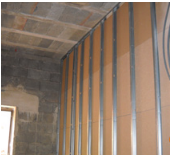
Zwischenwand Ständermontage
