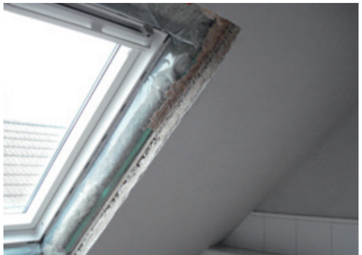
Nachträgliche Dämmung Dachschräge
