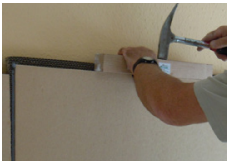
Direktmontage Wand für Schallschutz
