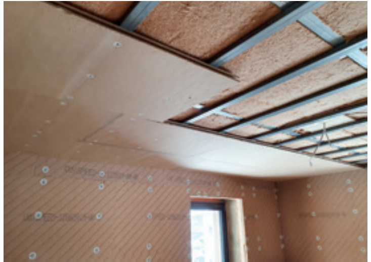
Deckenmontage auf Metallständer
