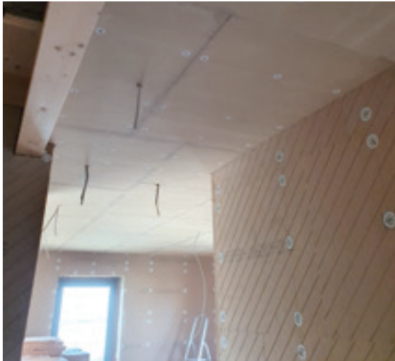
Deckenmontage Holzbalkendecke
