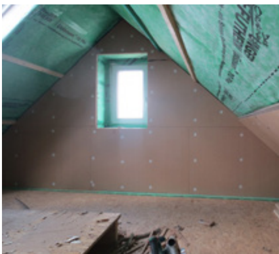
Dachausbau als Untersparrendämmung
