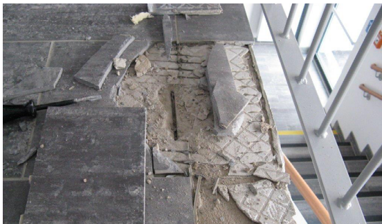
Sanierungsmaßnahmen an Stiegenbauteilen durch Öffnen der Trennfugen und Entfernen der Schallbrücken
