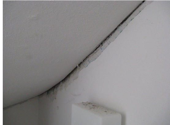
Sanierungsmaßnahmen an Stiegenbauteilen durch Öffnen der Trennfugen und Entfernen der Schallbrücken
