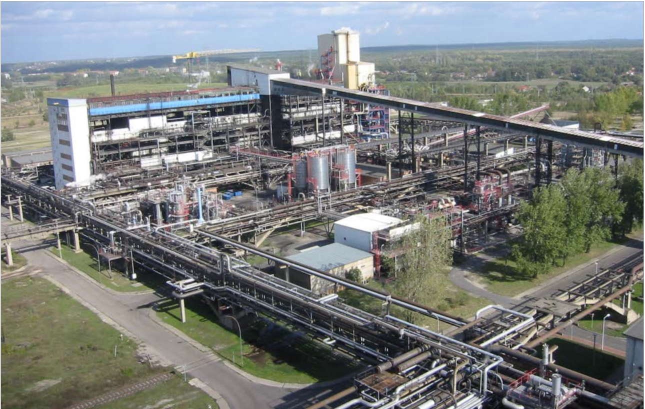
Abbildung 3.52: Festbettvergaseranlage mit Peripherie am Standort Schwarze Pumpe. Die Festbettreaktoren waren im Gebäude mit dem blauen Dach angeordnet (eigene Aufnahme 2003).
