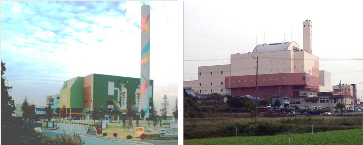
Abbildung 3.10: Ansicht der MES R21 Anlagen in Koga (links) und Toyahashi (rechts) [MITSUI 2004].
