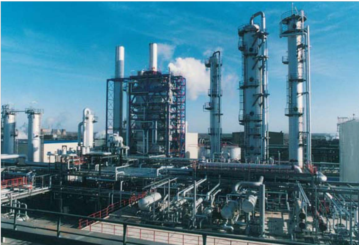
Abbildung 3.55: SVZ Schwarze Pumpe mit GuD-Kraftwerksblock (Bildmitte) und Methanolanlage (rechts) [SVZ 2003, zitiert in Thomé 1998].
