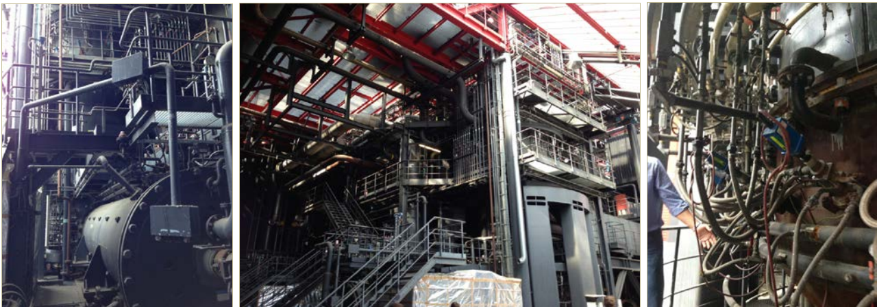
Abbildung 3.64: Thermoselect-Anlage in Karlsruhe nach jahrelangem Stillstand (eigene Aufnahmen 2014).
