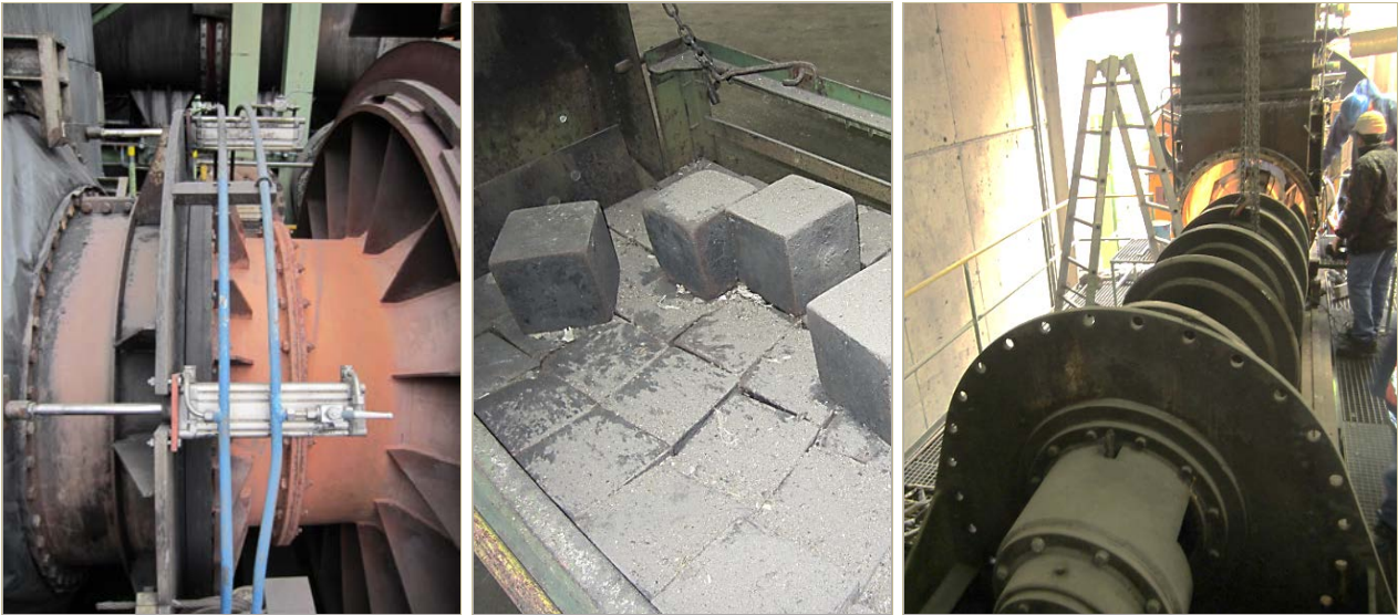
Abbildung 3.24: Drehrohrübergang mit Abdichtung, „Poltersteine“ zur Ablösung von Belägen im Drehrohrinneren und Zuführschnecke des Drehrohrs im ausgebauten Zustand (von links) an der MPA Burgau (eigene Fotos).
