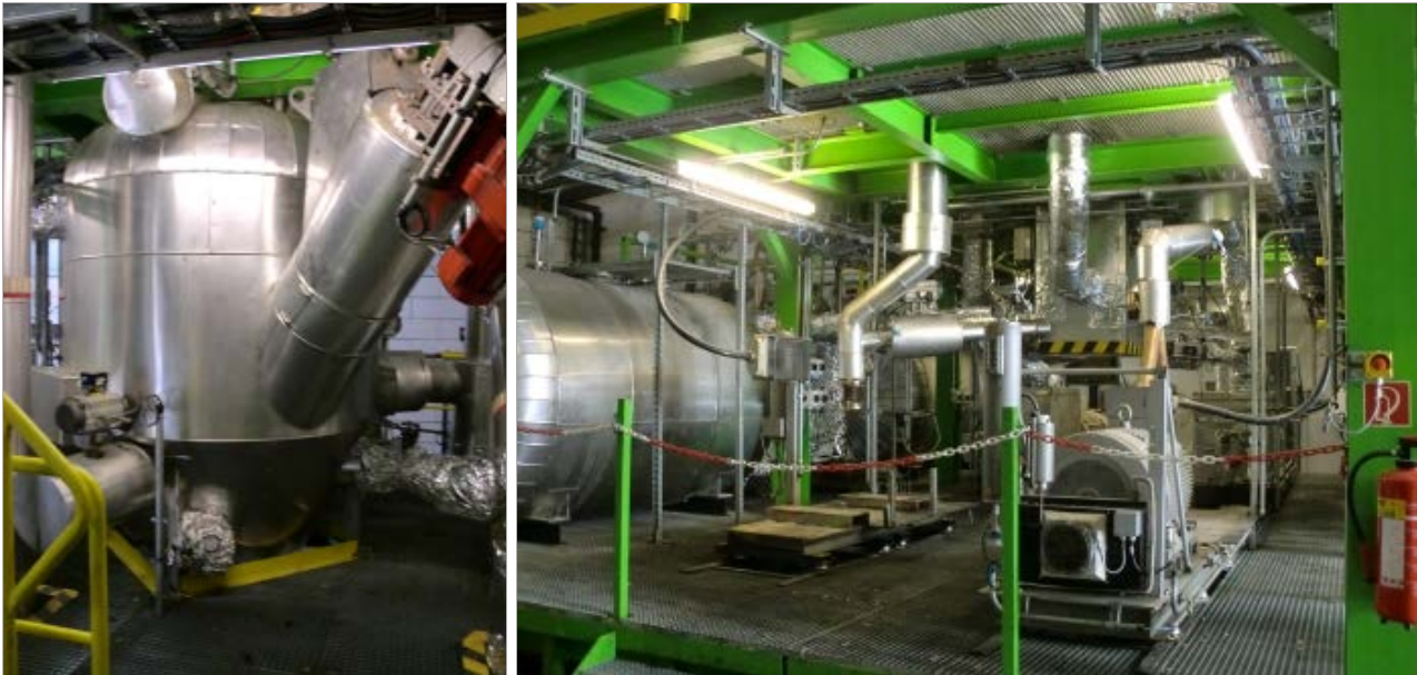
Abbildung 3.78: Links: Reaktor der Dieselwest-Anlage mit Schnecke für Brennstoffzufuhr, die den Brennstoff unter die Oberfläche des etwa zur Hälfte mit Öl-Feststoff-Gemisch gefüllten Reaktors fördert; rechts: Turbinen des Energieeintragungssystems (eigene Fotos).
