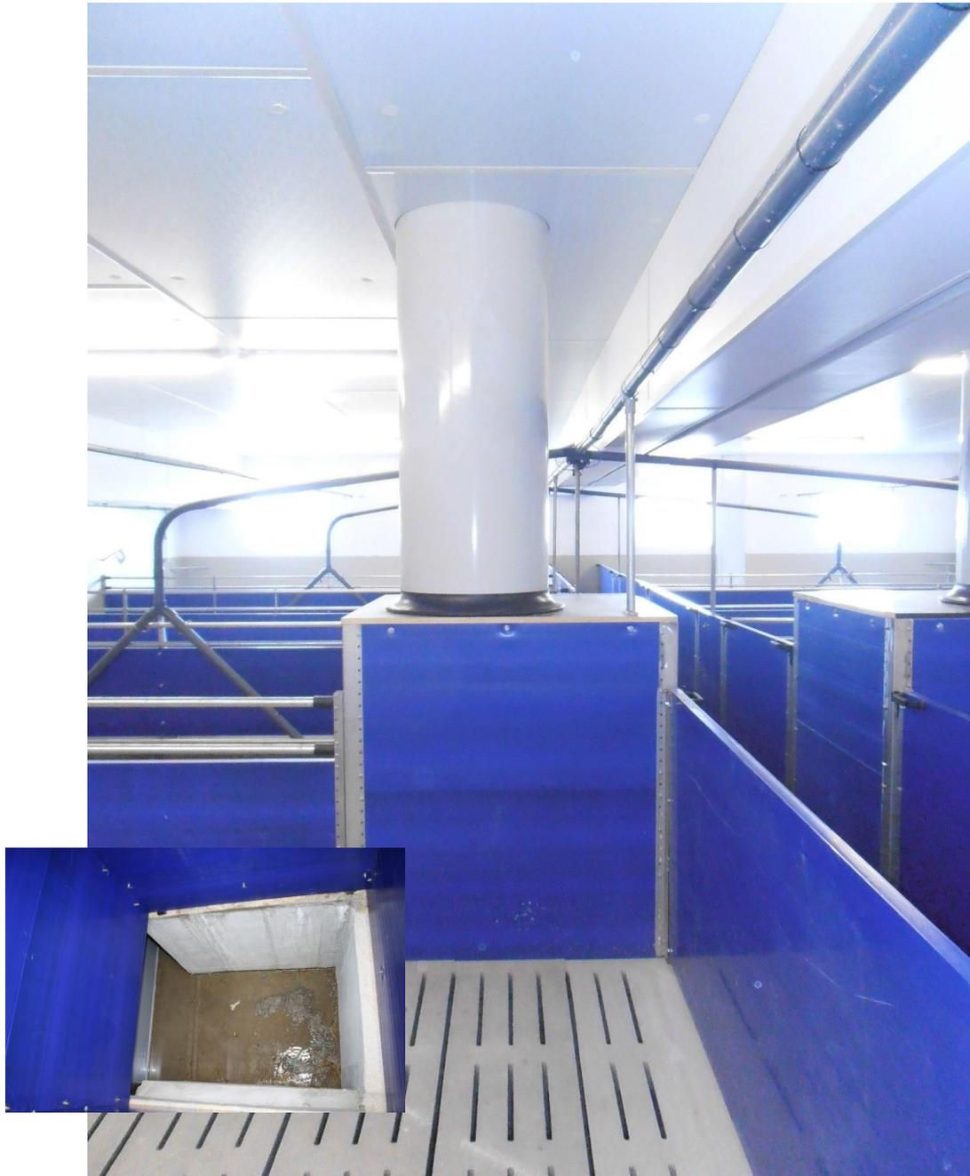
**Abbildung 12:** Schweinebucht – Zentral ist die Unterflurabsaugung erkennbar. Der Abstand zwischen Güllegrund bis zur Absaugöffnung beträgt 100 cm (Bild links). Hier werden maximal 30 % des geforderten Volumenstroms abgesaugt und der dreistufigen Abluftreinigungsanlage zugeführt.
