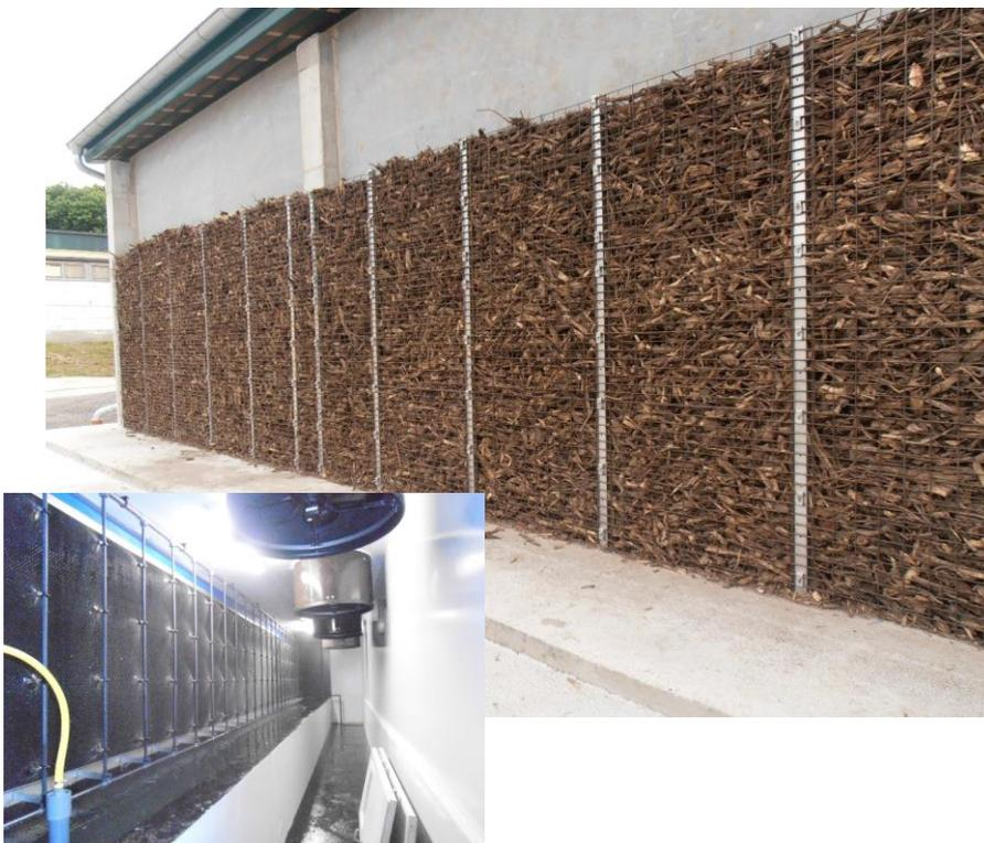
**Abbildung 12b:** Abluftreinigungsanlage – Zum Einsatz kam ein „handelsüblicher“ dreistufige Abluftreinigungsanlage. Die Besonderheit lag in der Dimensionierung des Wäschers. Er ist für lediglich 30 % des Volumenstromes ausgelegt.
