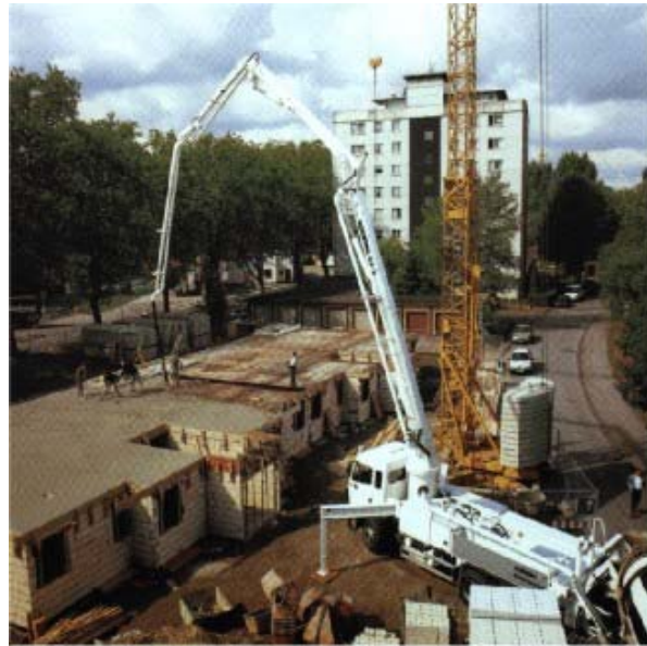
Betonverteiler auslegerarm der Fa. Schwing, Herne
