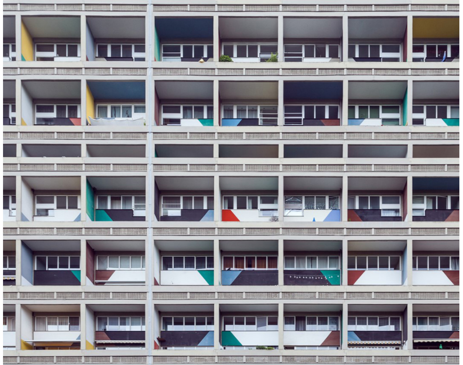
Fassade des Corbusierhauses in Berlin
