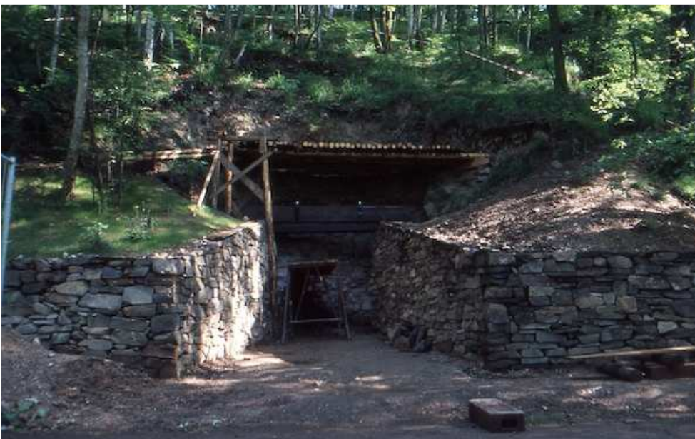
Bild 11: Einbau der Kappen aus mächtigen Kanthölzern für das künftige Mundloch.
