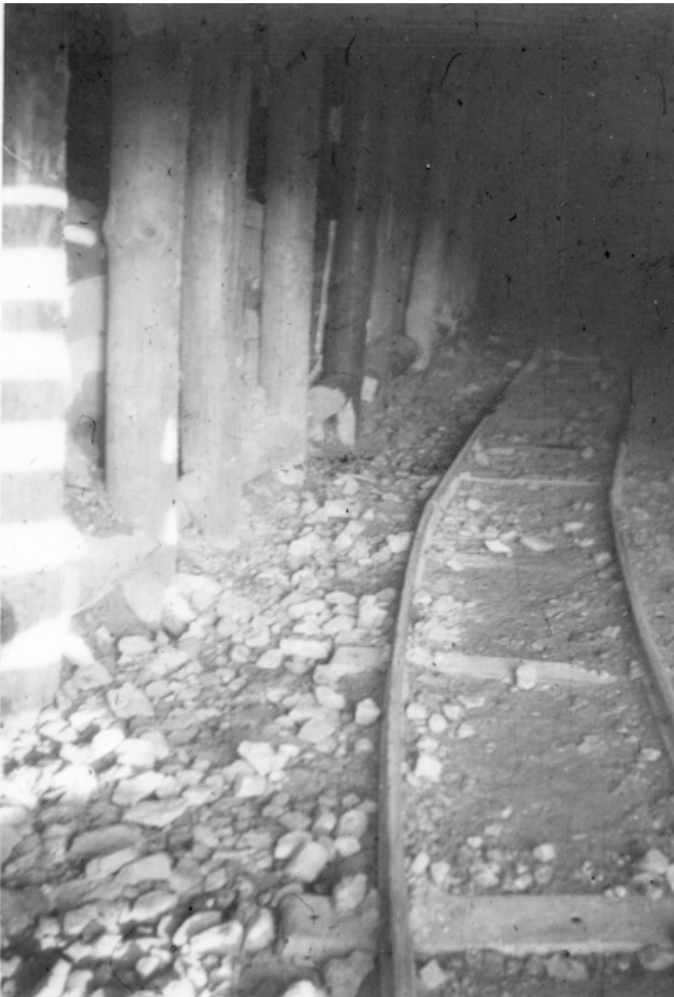
Bild 5: mittels Türstöcken ausgebautes Mundloch mit Gleisanlage für Steinbruchloren mit 600 mm Spurweite.
