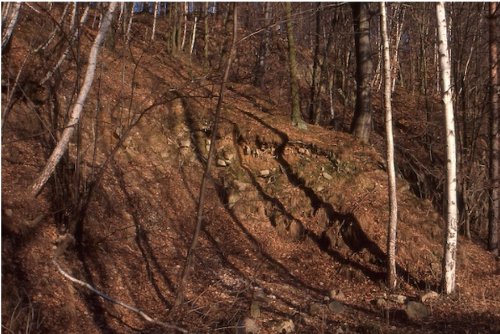
Bild 3: verwahrtes Mundloch des sogenannten Pegmatitstolln vor der Aufwältigung.
