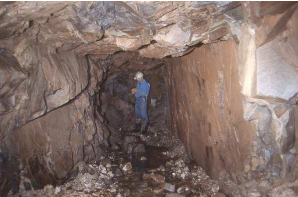
Bild 16: Der mit dem Stolln verfolgte Gang verlief am rechten Stoß. Einige kleine Stücke Runit konnten noch geborgen werden.
