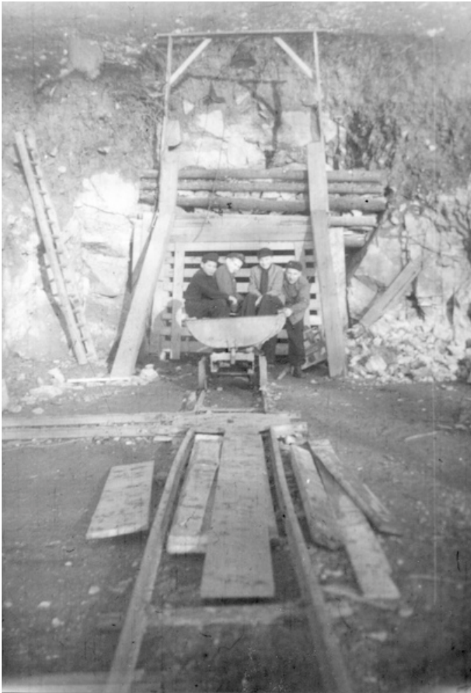
Bild 4: Mundloch des Pegmatitstolln während der Prospektionsarbeiten. Die auf dem Bild sichtbaren Jugendlichen gehören wohl zur Bergbaugruppe RKW, eine der ersten Montanforschungsgruppen nach Ende des zweiten Weltkrieges im Zschopautal zwischen Frankenberg und Mittweida.
