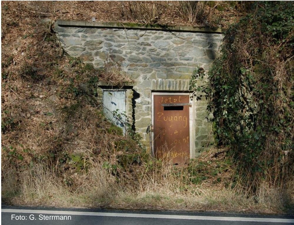
Grube „Bleizeche I“ unterer „Altfalter- stollen“ an der Weitalstraße
