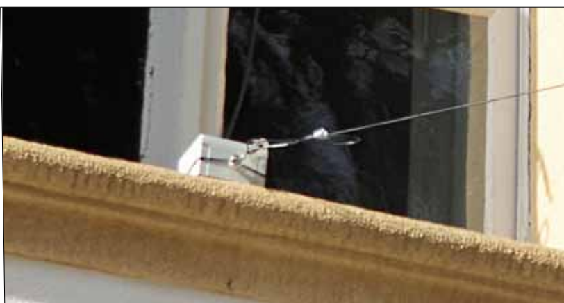
Balun de l'antenne "End Fed"
