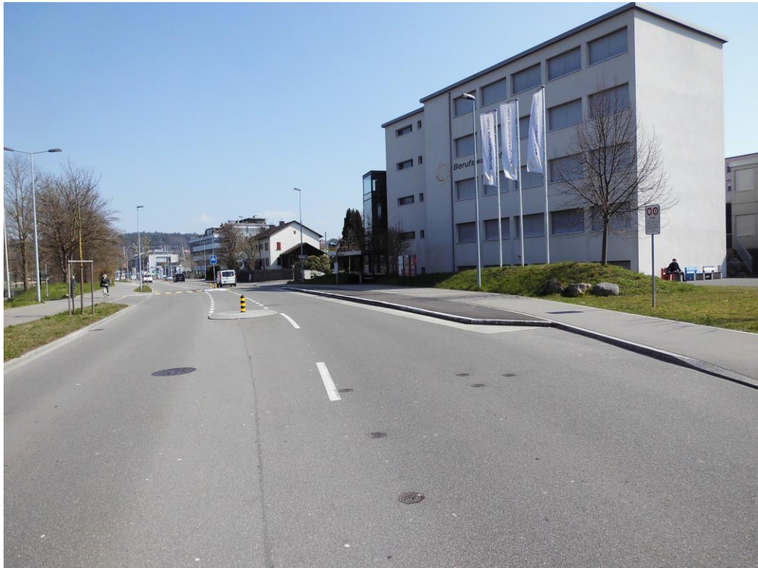
Foto 7 Haltekante Reithalle Fahrt- und Blickrichtung Wermatswil
