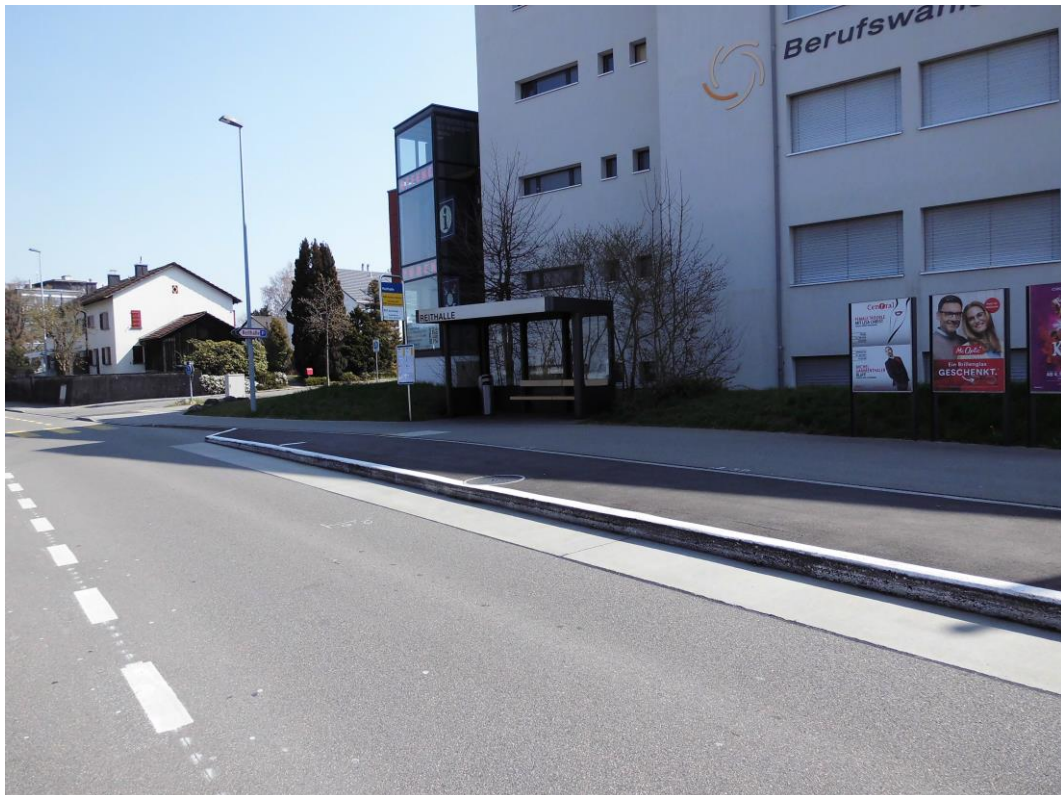
Foto 8 Haltekante Reithalle Fahrtrichtung Wermatswil
