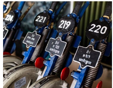
Nahaufnahme Weichenhebel in einem mechanischen Stellwerk (Kassel Rbf).
