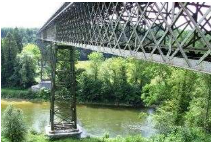
Bild 3: Thurbrücke Ossingen , 1873-1875, der Bahnlinie Etwilen – Winterthur
