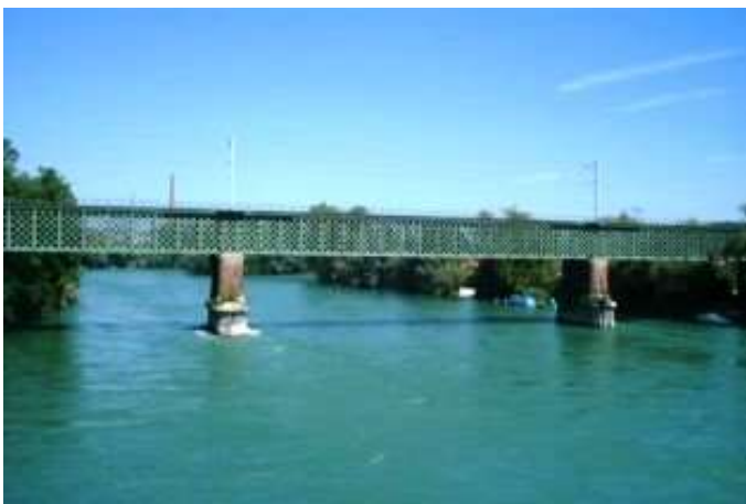
Bild 4: Rheinbrücke Waldshut - Koblenz , 1858-1859, die einzige, in ihrem Originalzustand erhaltene Gitterbrücke Europas.
