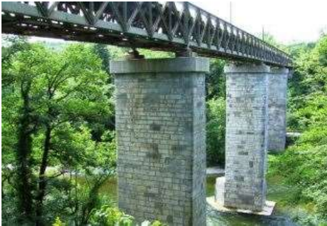
Bild 2: Thurbrücke Andelfingen der Verbindung Winterthur-Schaffhausen
