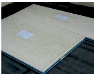
Verlegung laut Verlegeplan
