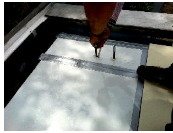
Durchdringungen mit PU-Schaum abdichten
