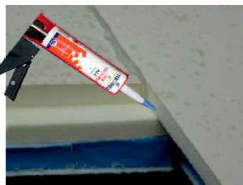
Verklebung mit PUR-Kleber
