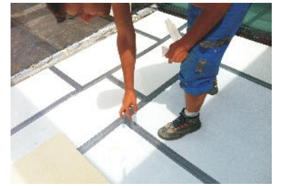
Fertig verlegte Fläche
