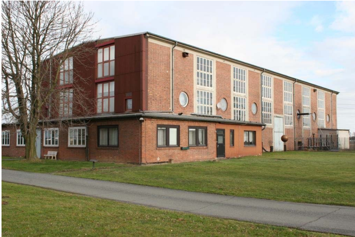
Bild 15 Versuchsanlage Hallendorf des Hochspannungsinstituts der TU-Braunschweig, Quelle: Autor 2007
