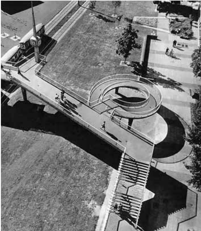
Abb. 4 Fußgängerbrücke mit Rampe und Aussichtsplattform, Architekt Gerhard Guder.
