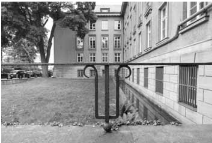
Abb. 2 Ehrenhof, bauzeitliche Einfriedung, Detail, Juni 2012.
