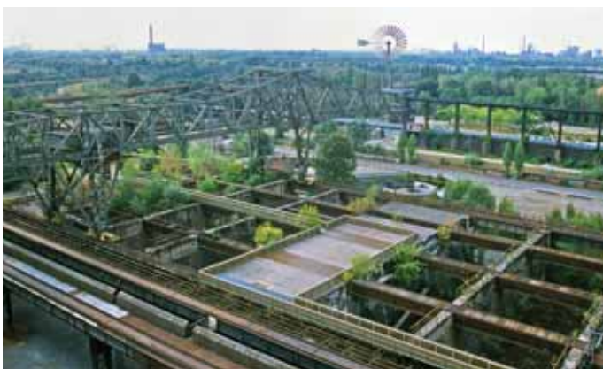
Abb. 1 Blick vom Hochofen 5 über die Möllerbunker zur ehemaligen Sinteranlage, 2011.
