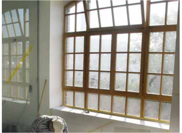
Abb. 5 Original rekonstruierte Fenster mit Einscheibenverglasung.
