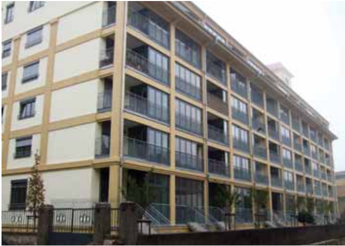
Abb. 5 Ehemaliges Hafermagazin, Landau, nach Konversion (Wohnungen).
