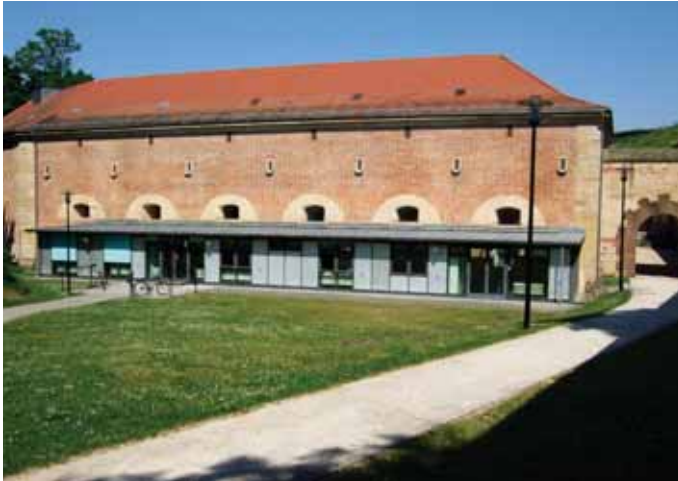
Abb. 7 Ehemalige Kaponniere der Fronte Beckers, Germersheim, nach Konversion (angefügte Büros der Musikschule).
