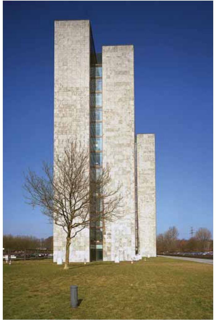
Abb. 7 HEW-Gebäude von Arne Jacobsen.
