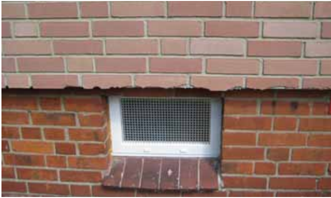
Abb. 6 Details mangelhafter Thermohautverkleidungen.
