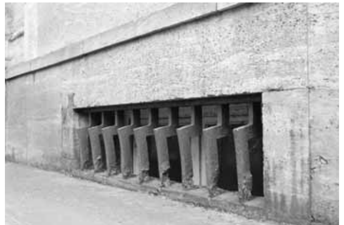
Abb. 4 Nordfassade, fünfschichtige Pfeilerhalle, Fenstergitter, Detail.
