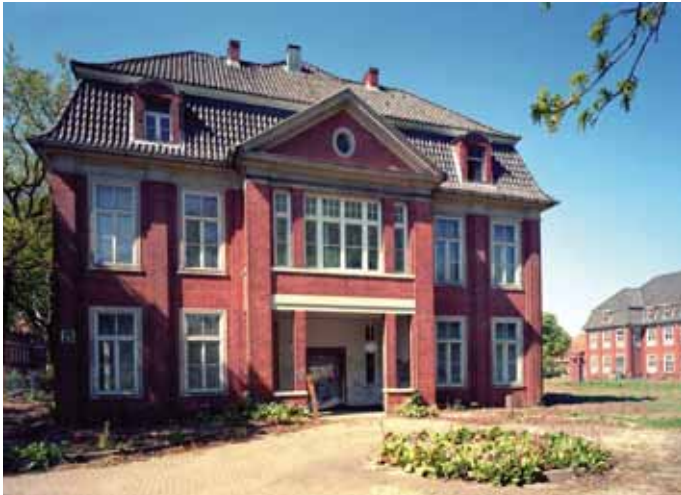
Abb. 7 Ehemaliges Allgemeines Krankenhaus Barmbek: zu Wohnungen umgenutzter Pavillon, 2013.
