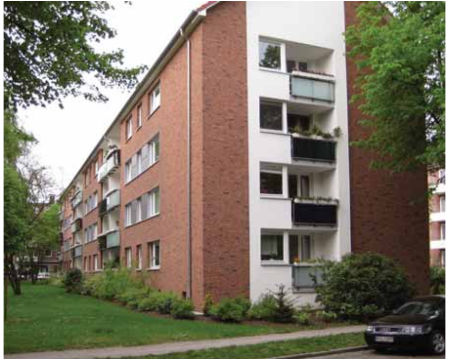
Abb. 6 Sanierung als gestalterische Aufgabe: Ein positives Sanierungsbeispiel eines Gebäudes aus den 1950/1960er Jahren.
