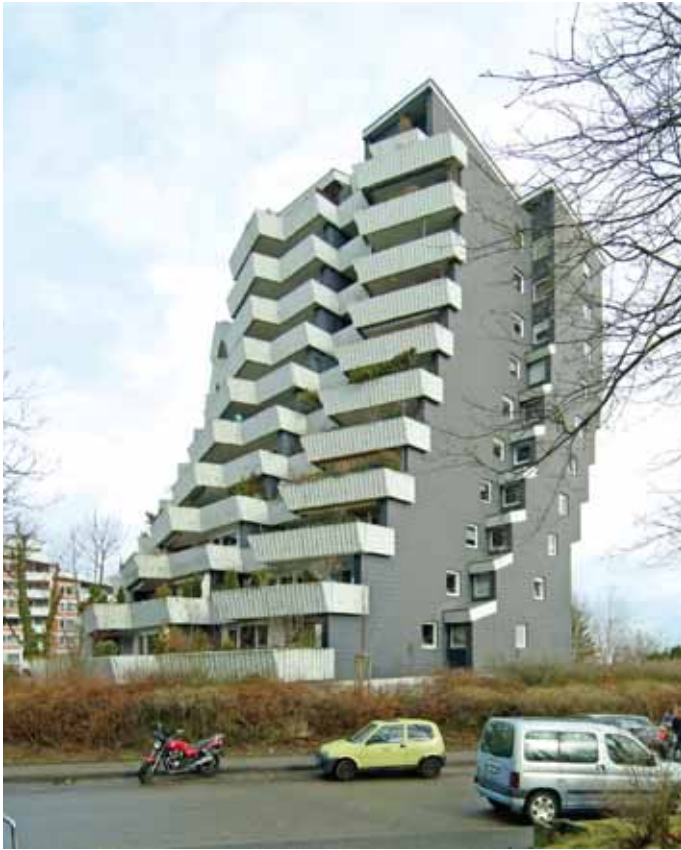
Abb. 2 Hemmingen, Terrassenhochhaus mit vertikal strukturierten, nach außen geneigten Betonbrüstungen vor dunkler Eternitfassade, 2011.
