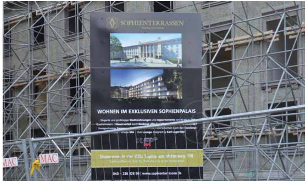
Abb. 8 Sophienpalais, „Denkmalrest mit Baudenkmalqualität“.
