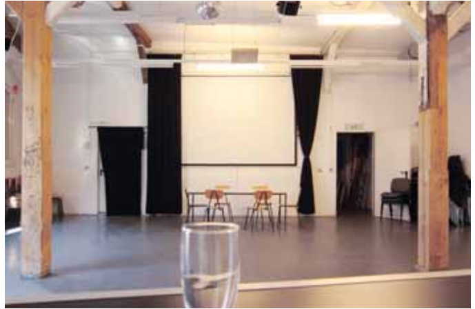
Abb. 1 Auch nach dem Umbau ist die tragende Balkenkonstruktion gut zu sehen.
