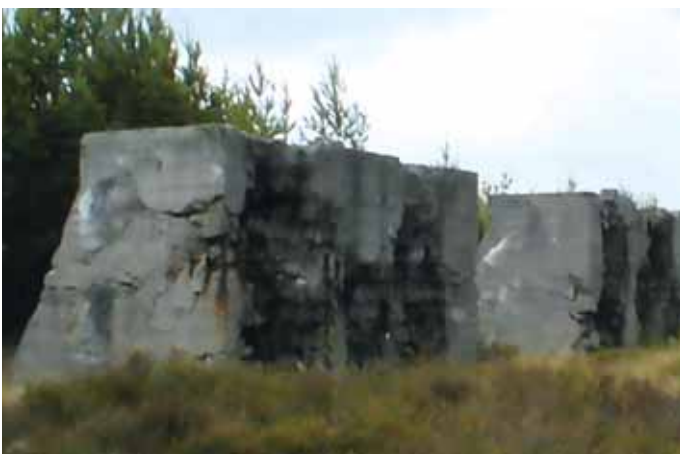
Abb. 4 Geschossfangkorb auf der Schießbahn West, 2009.
