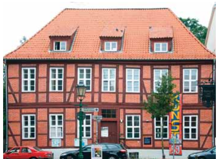
Abb. 3 Kanzlerhaus Harburg, Neue Straße 59.
