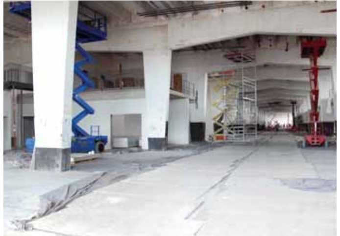
Abb. 8 Bremen, Überseestadt: Schuppen 1, Autowelt, während Umbau.
