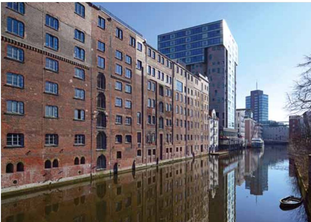
Abb. 1 Ehemaliger Mühlenbetrieb (Baudenkmal) und zum Bürohaus umgebautes Silo am Harburger Binnenhafen.
