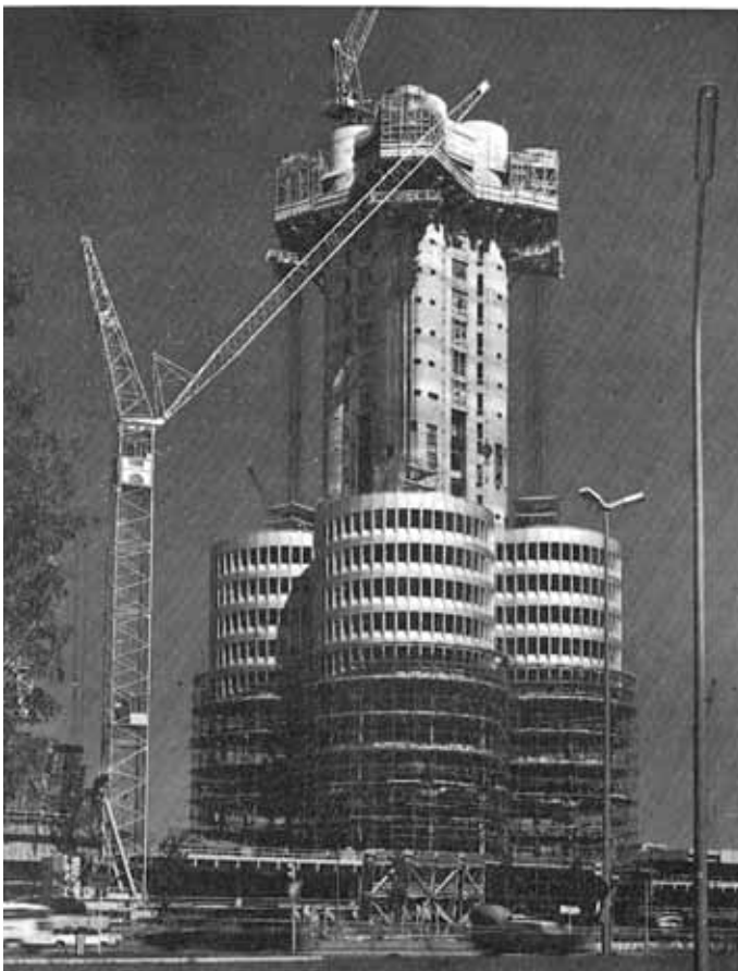
Abb. 5 München, BMW-Hochhaus im Bau.
