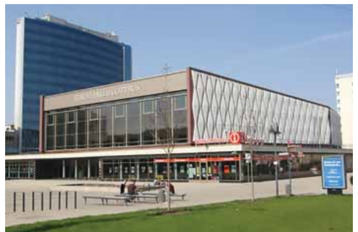
Abb. 3 Stadthalle Cottbus (1970–1975), Zustand nach Sanierung, Architekt Eberhard Kühn (Wettbewerb).
