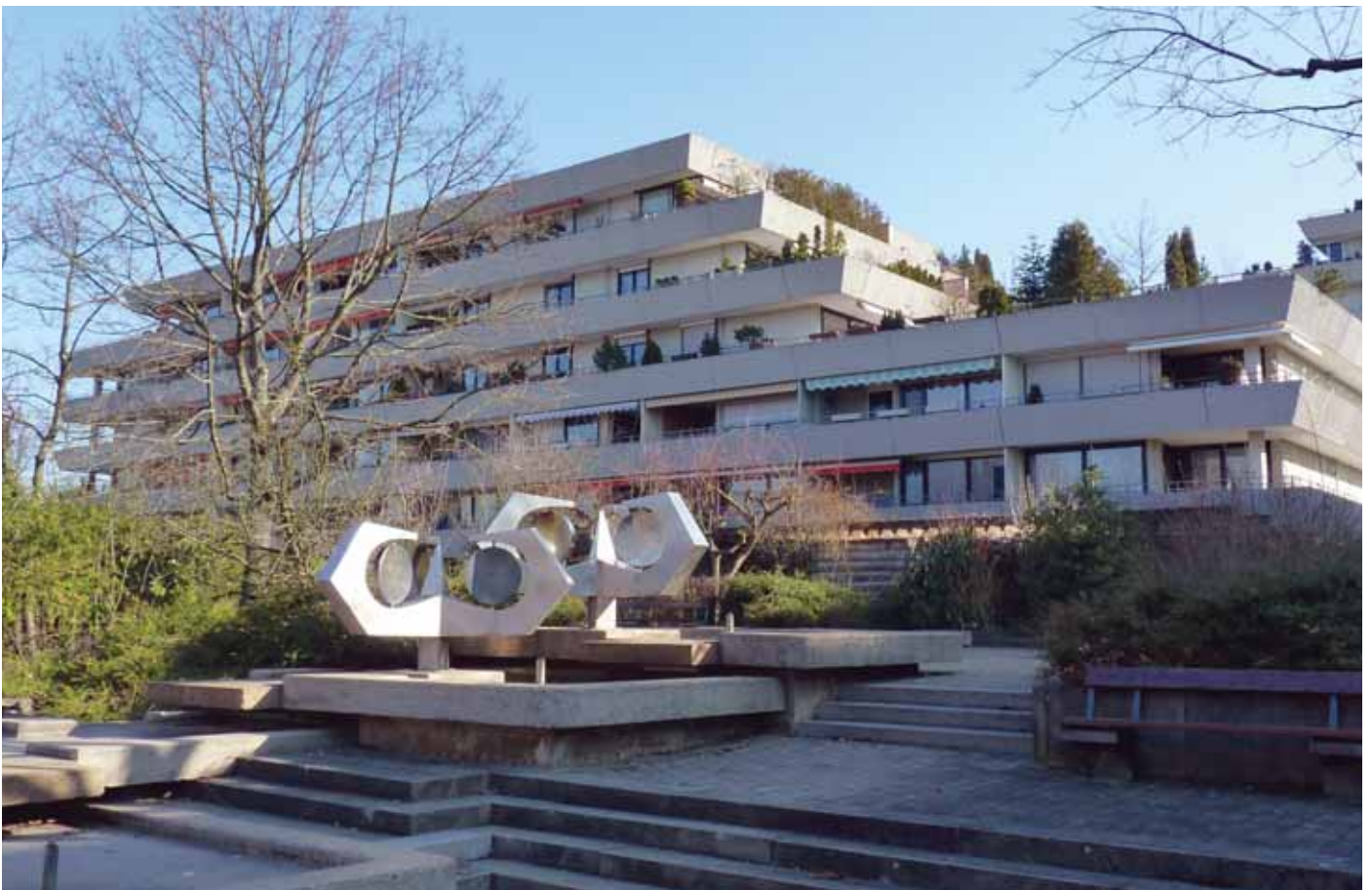
Abb. 5 Stuttgart-Heumaden, Siedlung Hochholz, zentraler Platz mit Brunnen zwischen den terrassierten Geschosswohnungsbauten, 2010.
