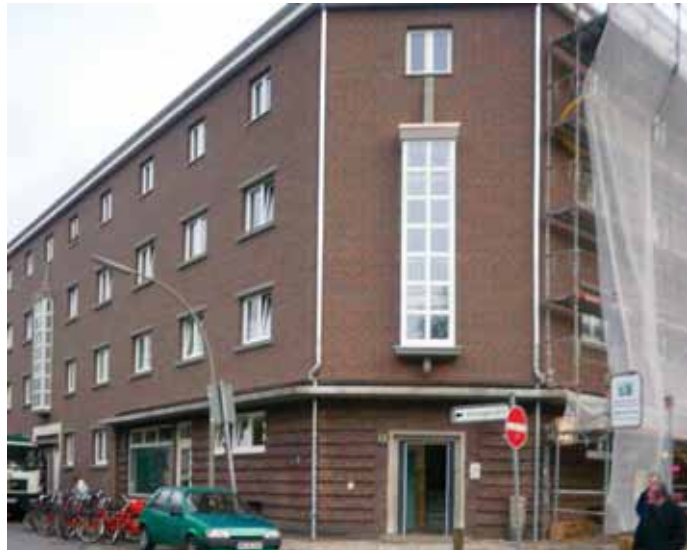
Abb. 3 Gutgemeinte Verschlimmbesserung: Gedämmtes Wohnhaus aus der Zwischenkriegszeit in Hamburg-Dulsberg. Applizierte Klinkerimitate sollen über den Gesichtsverlust hinwegtäuschen. Aufnahme 2009.
