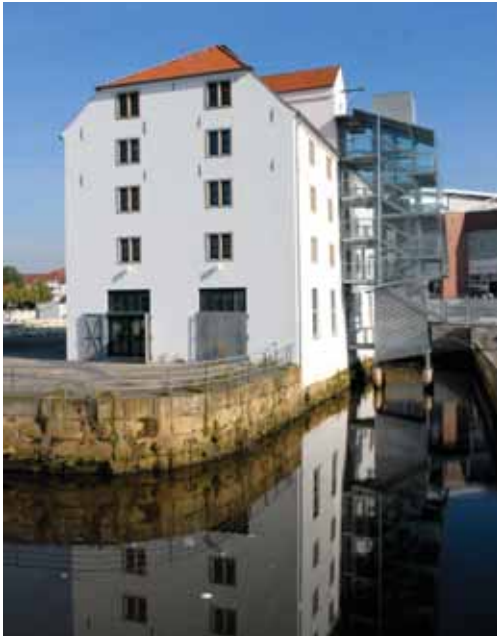
Abb. 2 Bremen, Vegesack: Lange-Speicher, Außenerschließung.
