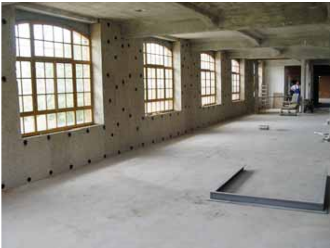
Abb. 4 Innenansicht einer Außenwand mit 50 Millimeter HWL-Platten belegt.
