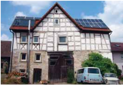
Abb. 5 Baudenkmal als Kraftwerk: Fachwerkhaus mit Solaranlage im Eichsfeld. Aufnahme 2005.
