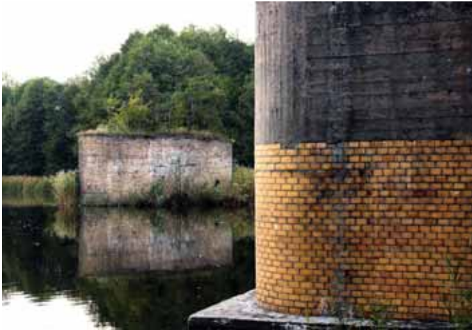
Abb. 5 Brückens Pfeiler der Eisenbahn pioniere im Schumkasee, 2010.
