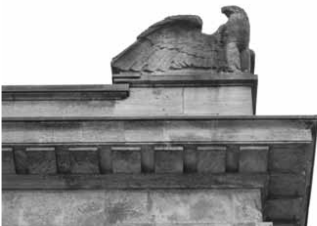
Abb. 3 Nordfassade, fünfschichtige Pfeilerhalle, Detail, Juni 2012.
