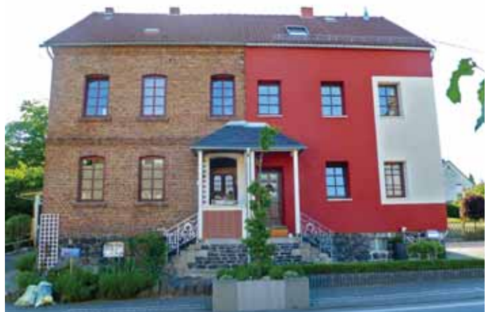
Abb. 4 Nachbarschaftlicher Zusammenstoß der Kulturen: Links eine schonende Sanierung, rechts eine zerstörerische Verjüngungskur. Die Fotografie, irgendwo in Deutschland entstanden, wurde – offenbar ohne jede kritische Absicht – als Illustration zum Wikipedia-Artikel über Wärmedämmverbundsysteme verwendet. Aufnahme 2011.
