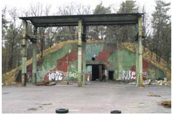
Abb. 8 Sonderwaffenlager, Lagerbunker Typ „Basalt“, Drucktor Eingangsbereich, 2012.
