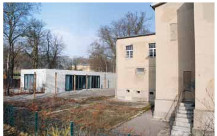
Abb. 9 Potsdam, Leistikowstr. 1, Neubau und Altbau, 27.1.2009.
