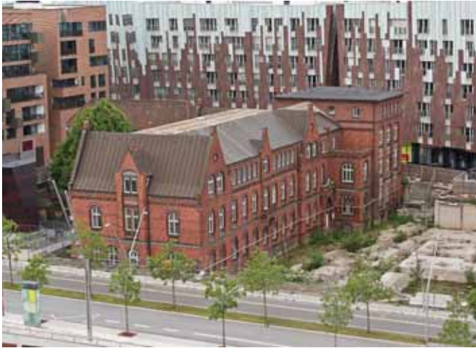
Abb. 9 Ehemaliges Altes Hafenamts in der HafenCity.
