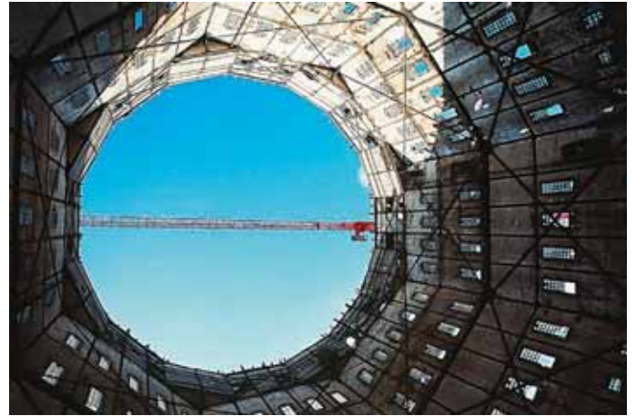
Abb. 3 Wasserturm Sternschanze, Auskernung vor dem Umbau zum Hotel.
