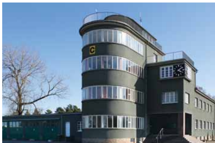
Abb. 5 Historischer Befehlsstand (Tower) nach der denkmalgerechten Sanierung, 2012.
