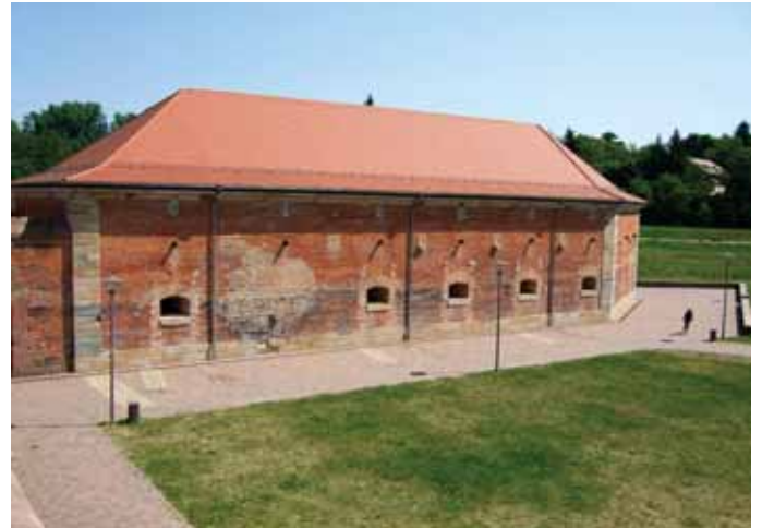
Abb. 8 Ehemalige Kaponniere der Fronte Lamotte, Germersheim, derzeit ohne Nutzung.
