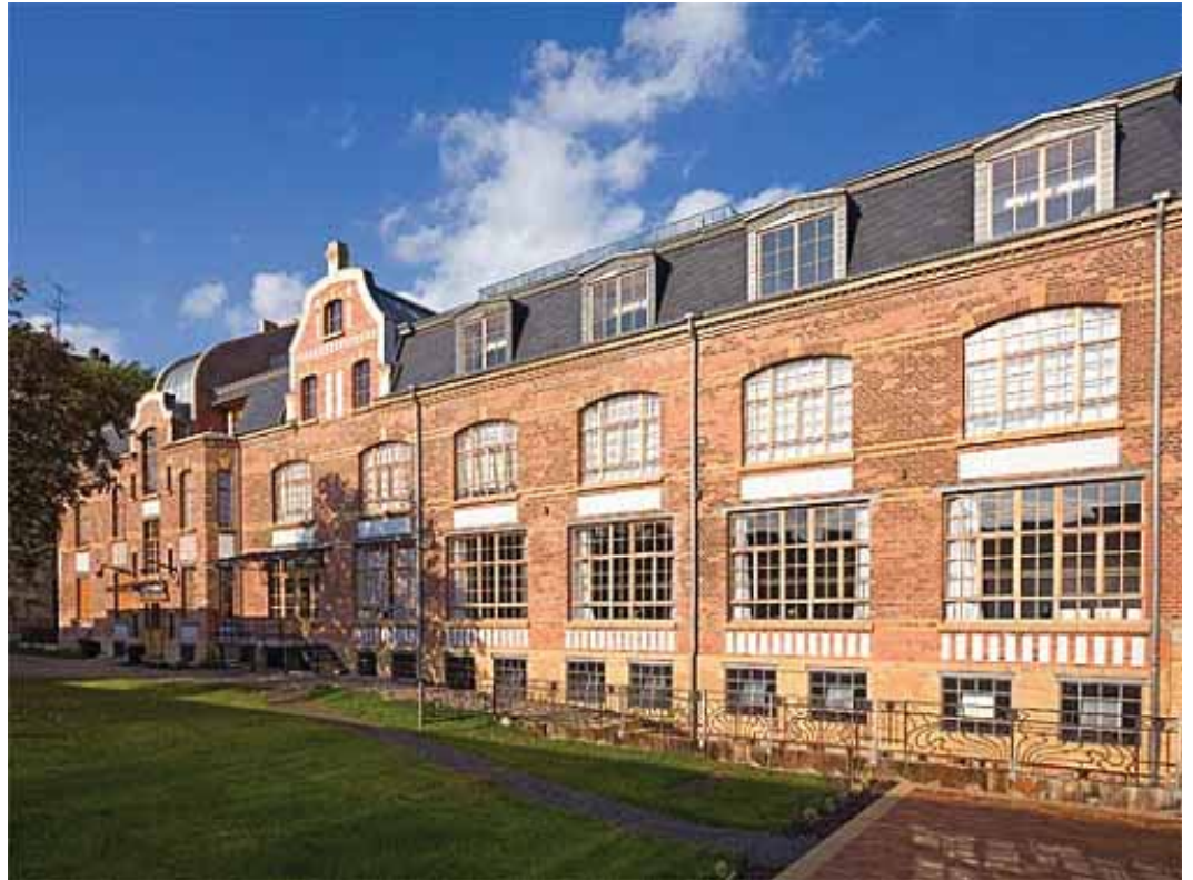
Abb. 7 Ansicht des Fabrikgebäudes von 1905 nach der Restaurierung.
