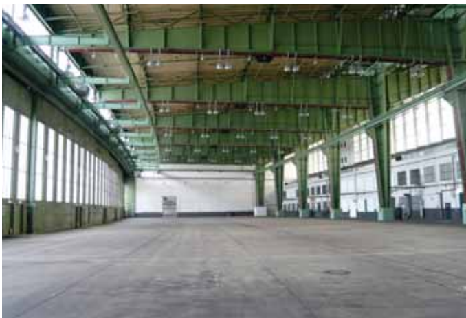
Abb. 9 Flughafen Tempelhof, Halle 6, Inneres nach Süd, 2012.
