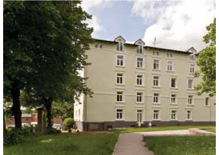
Abb. 10 Der zu einem Wohnhaus anverwandelte Teil des Harburger Schlosses, 2013.
