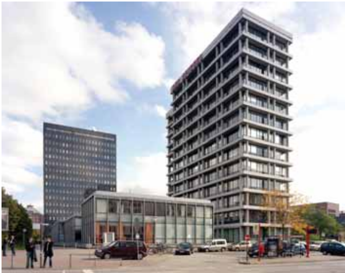
Abb. 5 Ehemaliges Spiegel- und IBM-Hochhaus (W. Kallmorgen 1965–1968).
