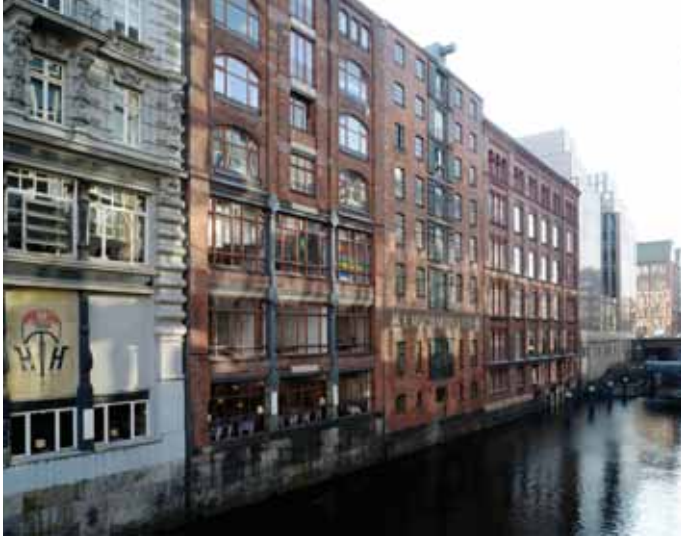
Abb. 3 Speicher am Herrengaben, 2013.
