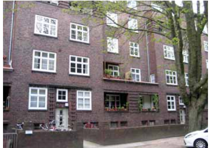
Abb. 5 Neue stilkonforme Fenster aus dem Sprossenfensterprogramm der 1980er/1990er Jahre.
