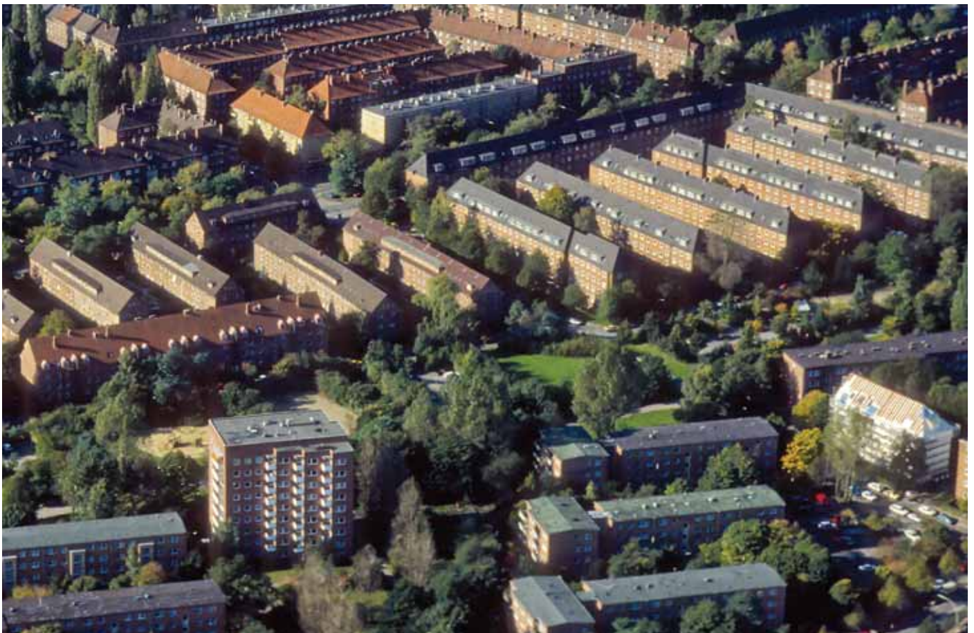
Abb. 10 Erhaltung der Backsteinstadt, Hamm, 1999.
