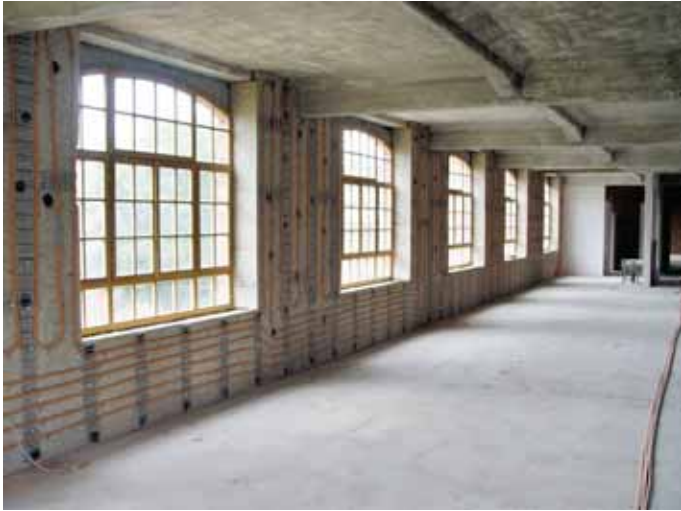
Abb. 3 Rohrleitungssystem der Wandflächentemperierung vor Verputz.
