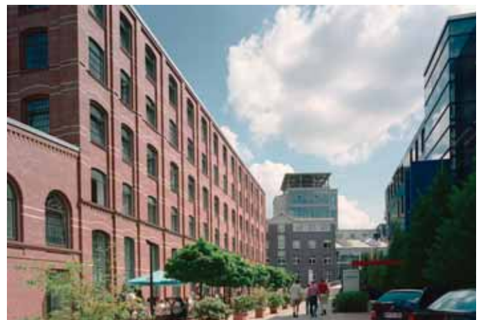
Abb. 4 Harburger Binnenhafen, ehemalige Industriebauten am Westlichen Bahnhofskanal.
