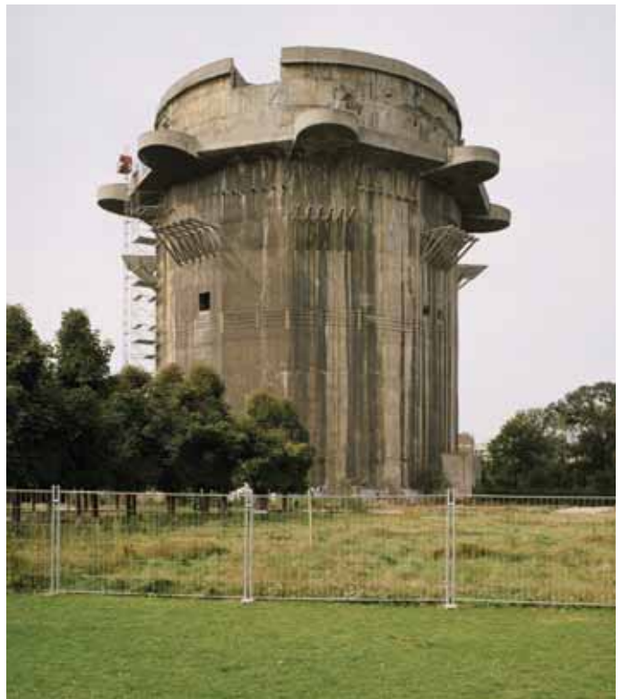
Abb. 8 Ehemaliger Flakturm, Gefechtsturm Augarten, Wien 2.
