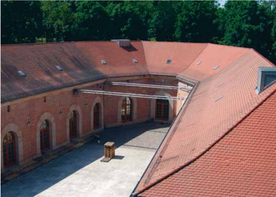
Abb. 6 Innenhof der ehemaligen Kaponniere der Fronte Beckers, Gemersheim, nach Konversion (Musikschule).
