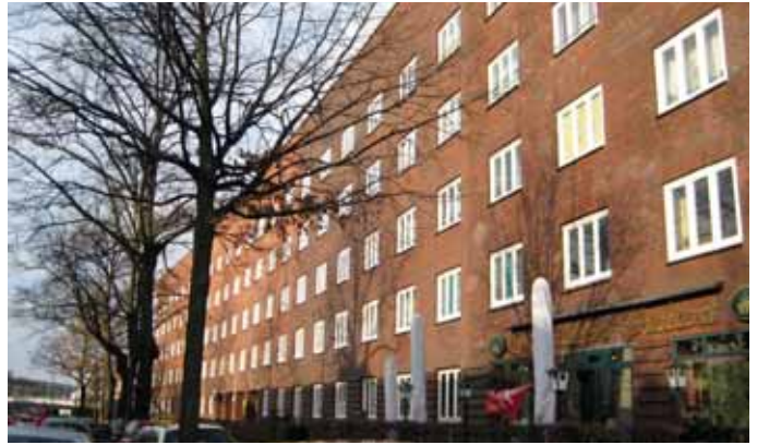
Abb. 7 Vorbildliche Fugensanierung und kompletter Rückbau in die Zweispännersystematik im Baublock an der Ecke Fuhlsbütteler Straße/Ring 2.
