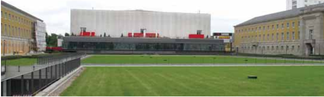
Abb. 11 Die ummantelte und zur Shopping-Mall umgewandelte Halle. Hinter der Membran sind die Betonlamellen erhalten. Der „Graben“ zeichnet sich im Gründach ab; auf Wunsch des Landesverwaltungsamtes wurde der Wettbewerbsentwurf, der eine Betonfläche vorsah, in der Ausführung verändert.
