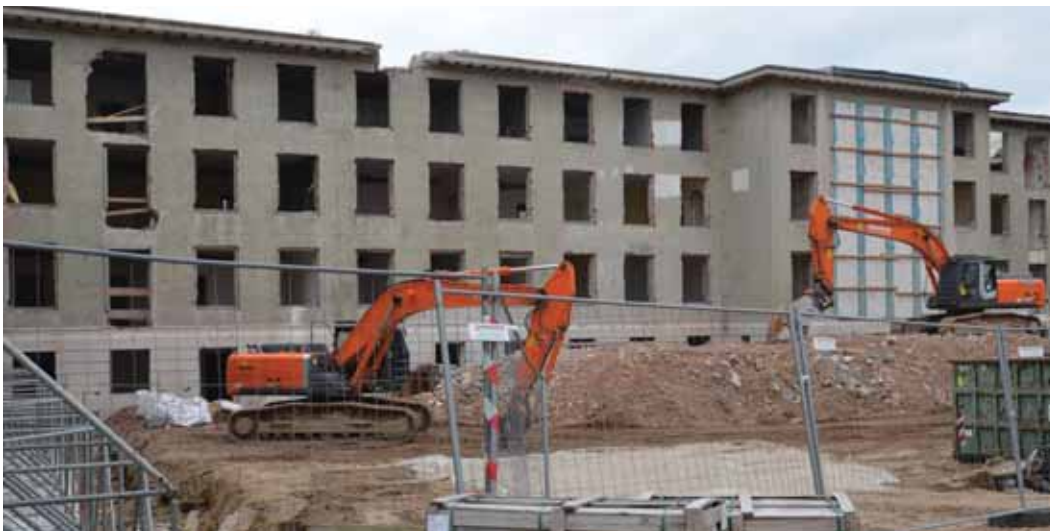
Abb. 7 Hoffassade, Zustand Oktober 2013.
