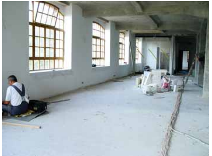
Abb. 6 Wandansicht nach Aufbringung des Innenputzes.
