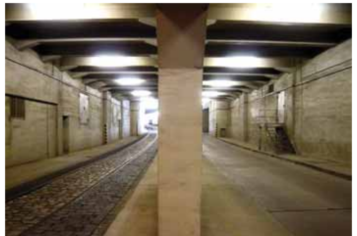
Abb. 10 Flughafen Tempelhof, Bunkerstraße mit Schienen und Fahrbahn, 2012.
