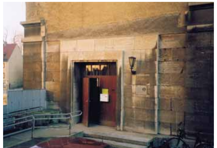
Abb. 6 Eingang zur Bibliothek der Hochschule für Architektur und Bauwesen im ehemals für den Reichsstatthalter bestimmten Südflügel. Erscheinungsbild seit 1987 (Anbau der Rollstuhlrampe) im Jahr 2000.
