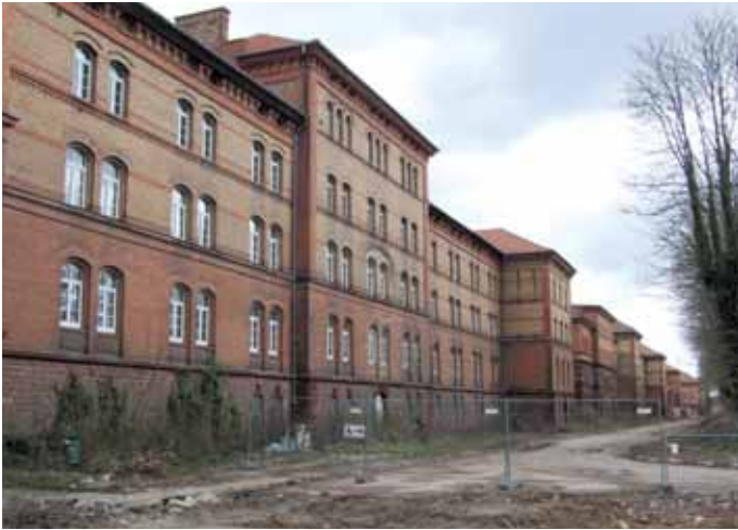
Abb. 2 Südansicht der ehemaligen Kasernen Estienne & Foche (Cornichonstraße), Landau.
