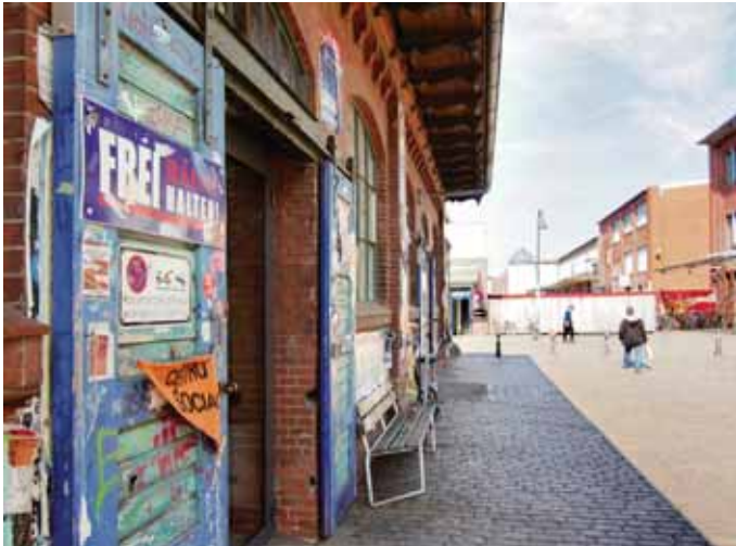
Abb. 4 Die alten Schiebetüren sind erhalten.
