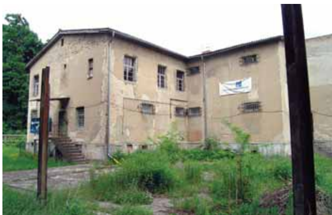
Abb. 8 Potsdam, Leistikowstr. 1, Südwestansicht, vor der Sanierung.
