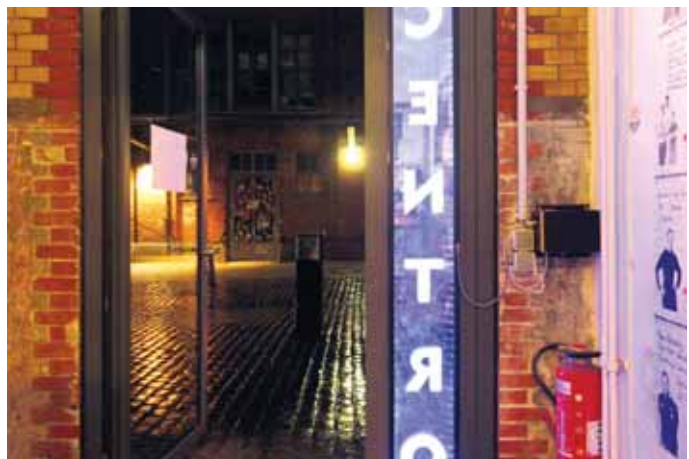
Abb. 3 Neue Türen in altem Gemäuer.
