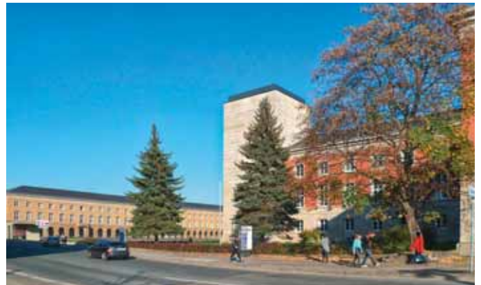
Abb. 13 Der Turm des ehemaligen Gauforums mit seinem neuen oberen Abschluss, der das flache Zeldach der 1950er Jahre ersetzte (vgl. Abb. 07).
