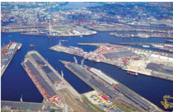
Abb. 1 Hamburg, Hafen, Luftbild des Bereichs Bremer Kai - Australiakai, 50er Schuppen, 1991.
