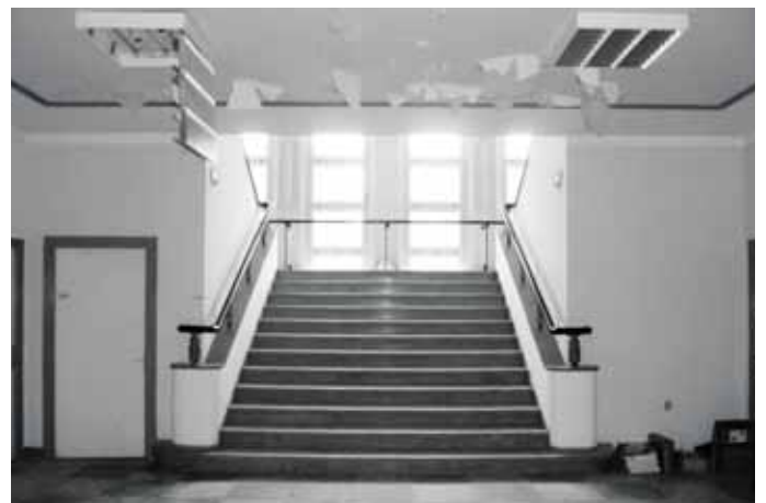
Abb. 5 Eingangshalle mit Treppenhaus, Zustand Juni 2012.
