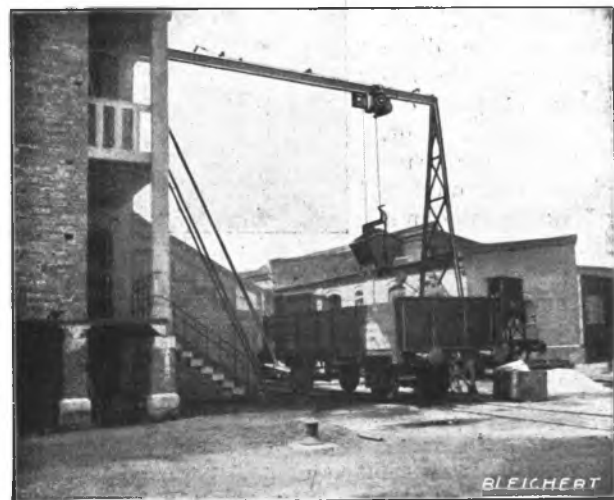
Fig. 85. Aufnahmen von Kohlen aus einem Eisenbahnwagen mit Bleichert'scher Elektrowindenbahn.
