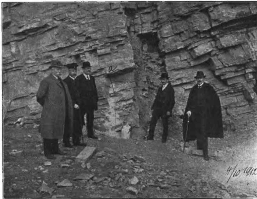
Abbildung Fig. 1. Das Füllen des Bohrloches mit flüssiger Luft. a = das Bohrloch, unten die Kanne.
