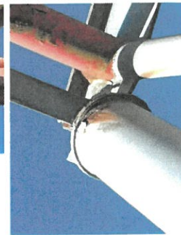
Knoten Fachwerk Pendelstütze
