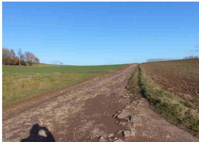
Abbildung 55: Wasserführender Weg mit Ausspülungen
