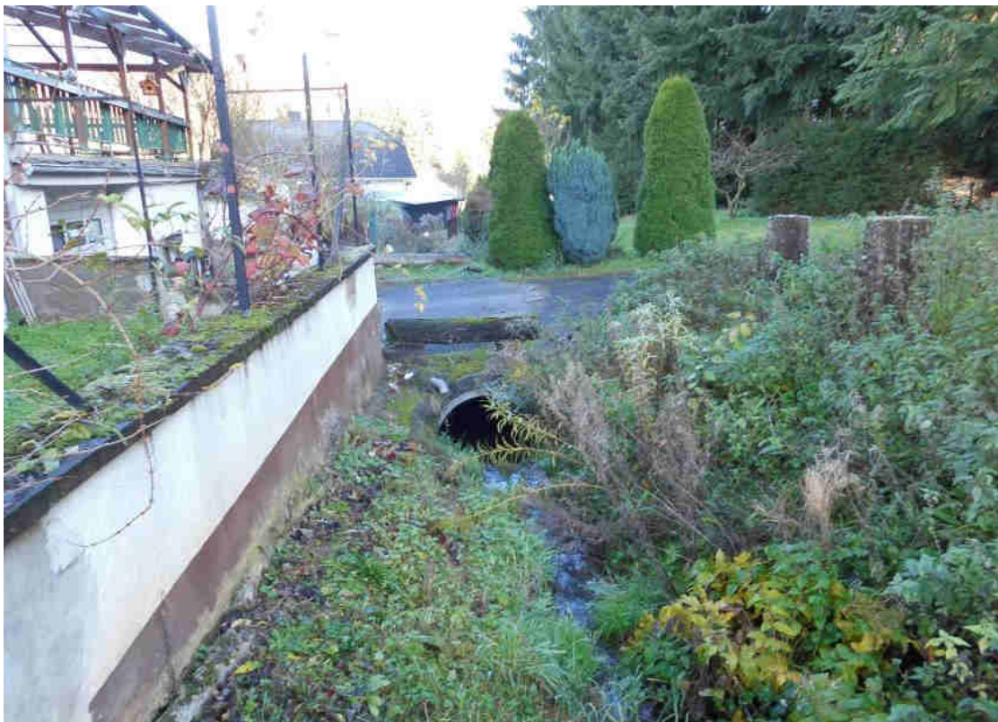
Abbildung 29: Durchlass DN 1000
