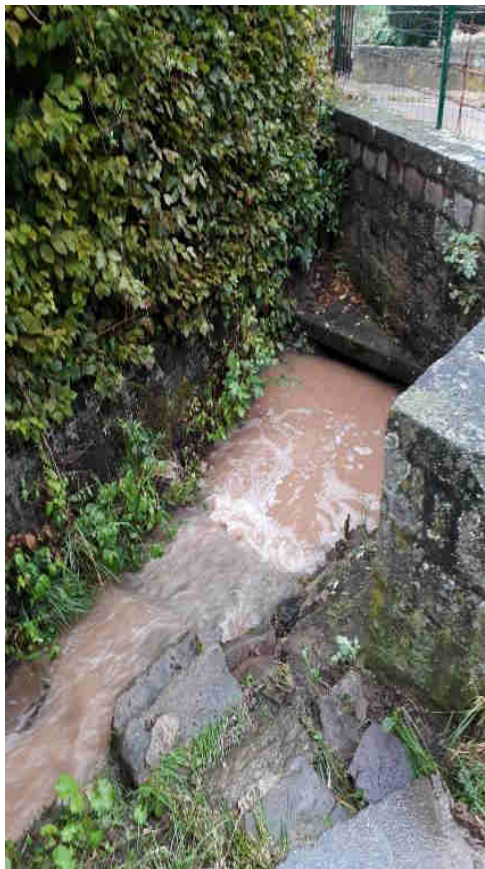
Abbildung 27: Einlauf mit Gewässerverrohrung (DN 1000)
