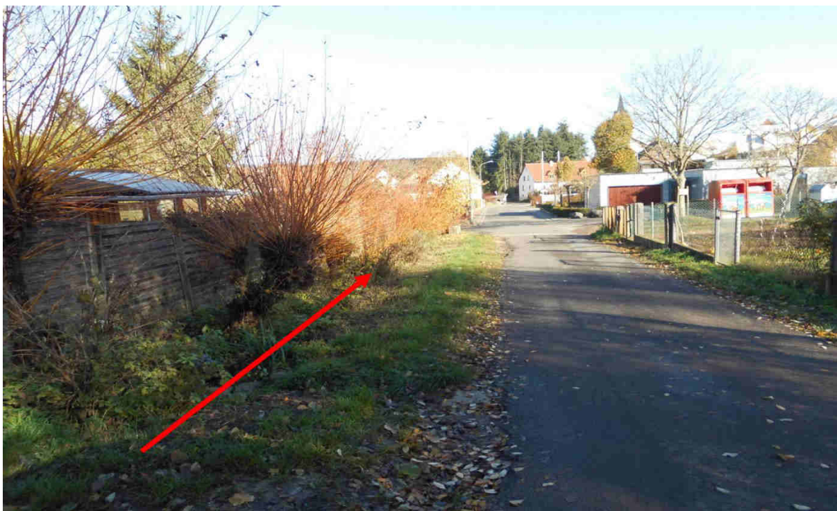
Abbildung 73: Weed/ Vorhandener Graben profilieren
