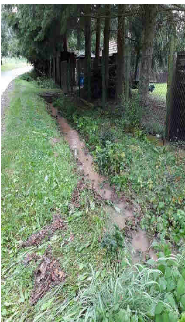
Abbildung 25: Graben mit Durchlass
