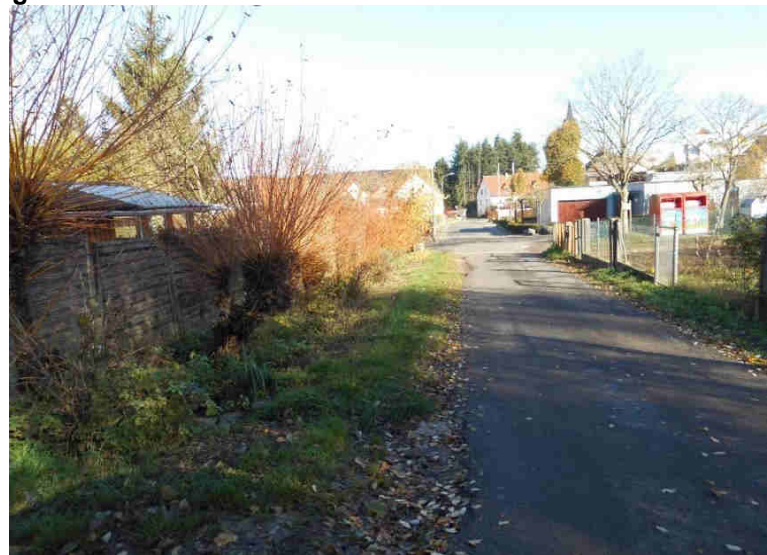
Abbildung 24: Graben seitlich des Wirtschaftsweges
