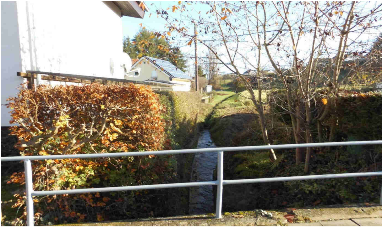
Abbildung 66: Götzenbach/ oberhalb Kapellenstraße
