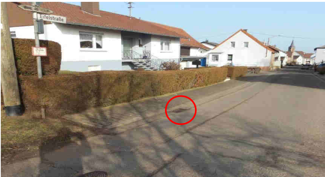
Abbildung 41: Einlauf in der Eifelstraße
