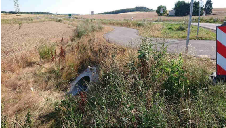
Abbildung 12: Auslauf unterhalb der Landstraße L379/ DN 600
