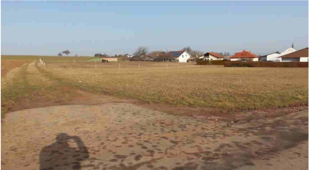
Abbildung 40: Erhöhter Feldweg zum Schutz der Bebauung
