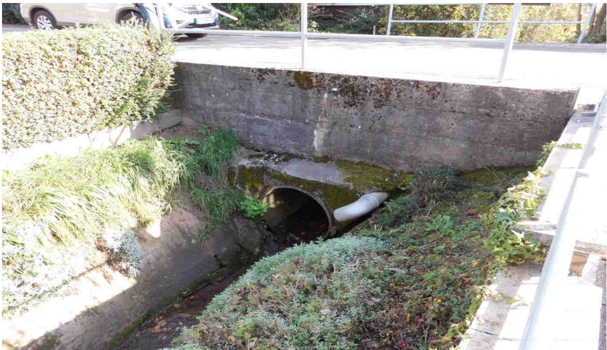
Abbildung 67: Götzenbach/ Durchlass DN 800
