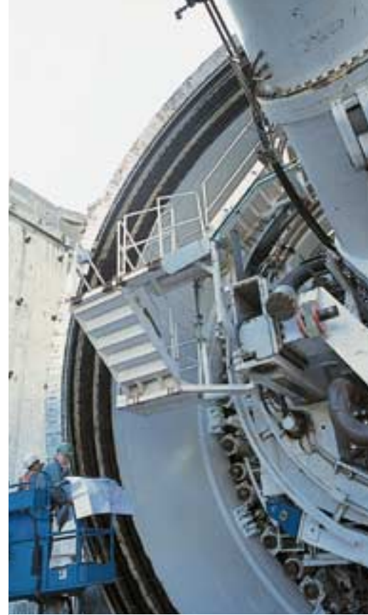
Im Pariser Raum sind die Vortriebsarbeiten West mit der Tunnelbohrmaschine an der A86 angelaufen. Der erste mautpflichtige Abschnitt wird im November 2004 eröffnet werden.
