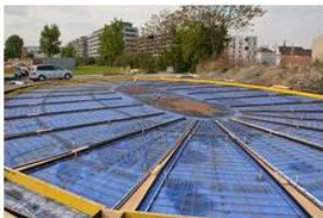
Zunächst wird auf einem Kunststoff-Pneu die Struktur errichtet.
