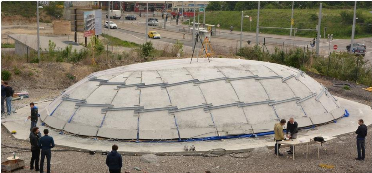
Der Kunststoff-Pneu unter dem Beton wird aufgeblasen - die Kuppel hebt sich.
