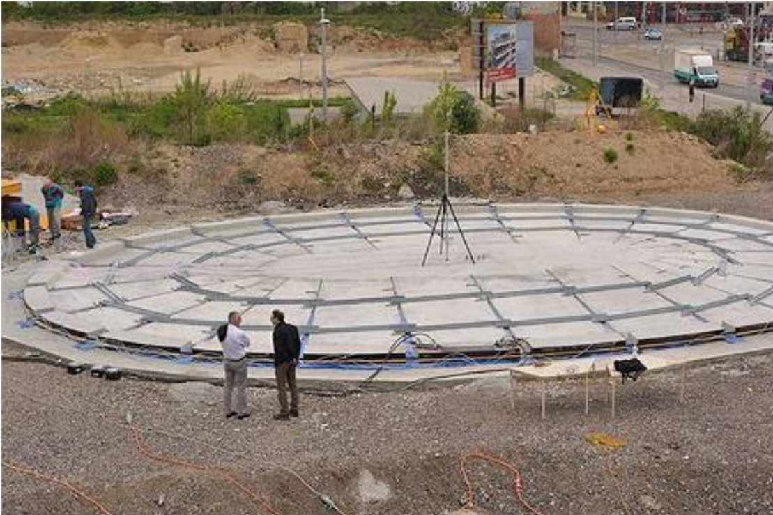
Noch liegt die künftige Kuppel als flache Betonplatte auf dem Boden
