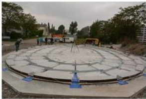
Die Form wird mit Beton ausgegossen.
