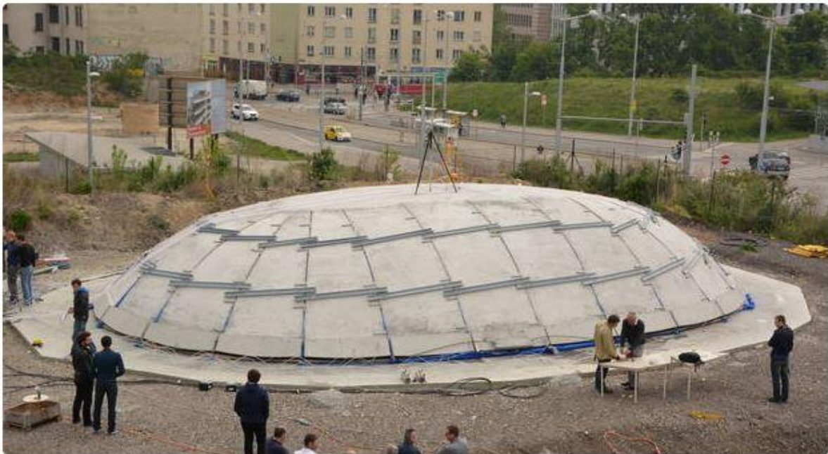
Eine fertig aufgeblasene Betonkuppel in Wien. - Foto: TU Wien
