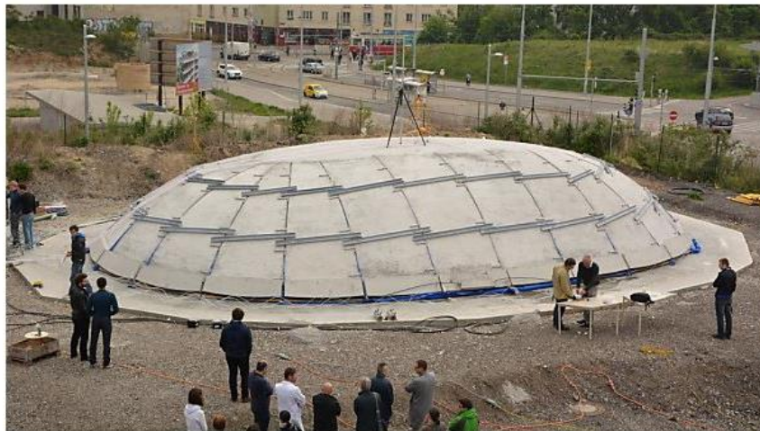
Luftkissen und Stahlseil sorgen dafür, dass sich der Beton hebt. Quelle: http://science.apa.at
