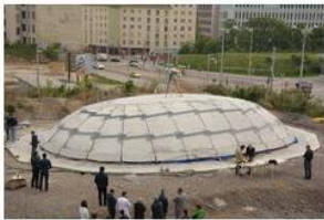
Die fertig "aufgeblasene" Betonkuppel
