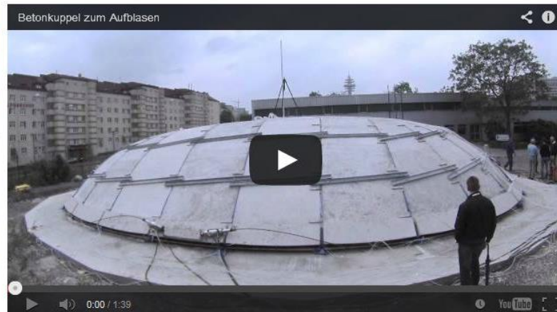
Zunächst wird auf einem Kunststoff-Pneu die Struktur errichtet.
