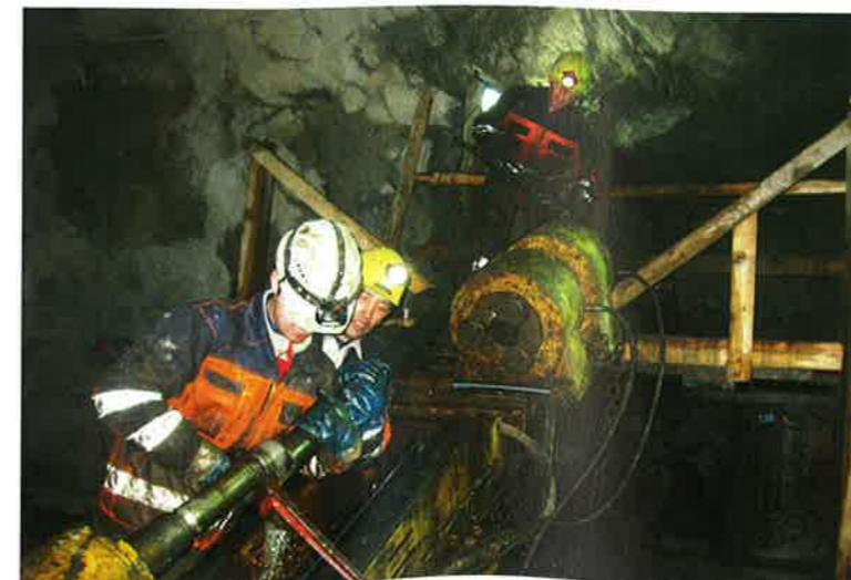
Abb. 3 – Gestängeausbau/Kernmarsch Doppelkernrohr
