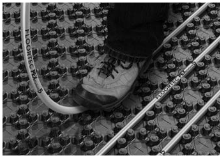
Abb. 1: Pe-Xcellent 5 Fußbodenheizungsrohr Verlegung
