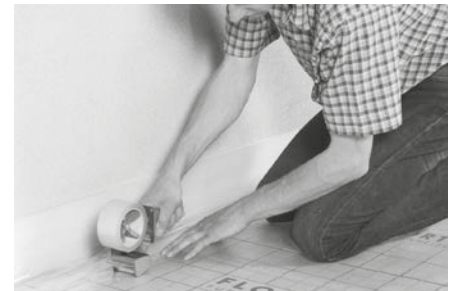
Randdämmstreifen (beim Einsatz von Fließestrich) abkleben.
