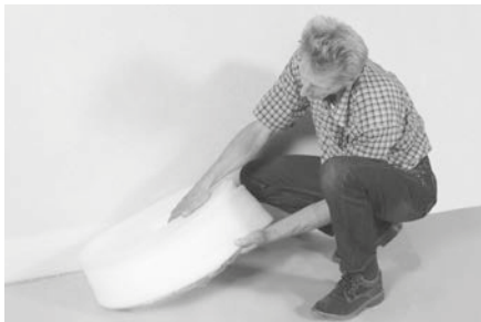
Randdämmstreifen mit seitlicher Folienschürze auslegen,
