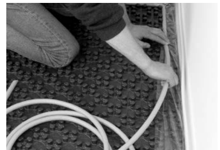
Abb. 2: Fixierung des Folienstreifens
