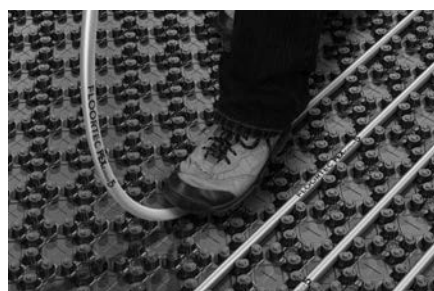
Schnelle und saubere Verlegung durch Überlappungstechnik.
