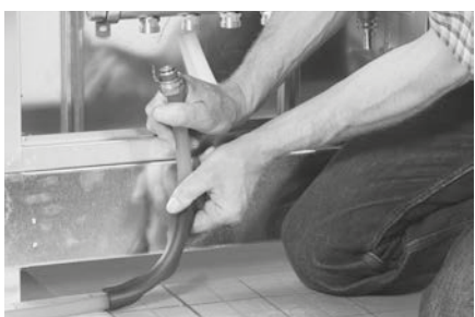
Heizrohr am Verteiler anbringen, fertig!
