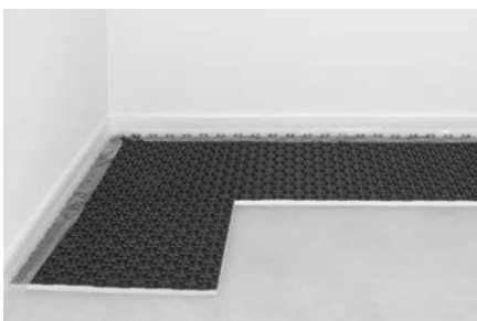
Mit dem abgeschnittenen Elementteil nächste Verlegereihe beginnen.
