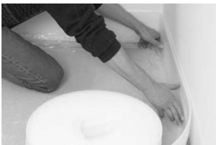
Randdämmstreifen mit seitlicher Folienschürze auslegen.
