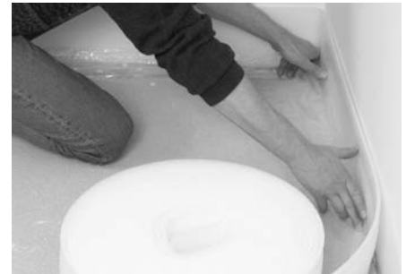
Abb. 1: Randdämmstreifen mit Folienstreifen
