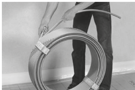
Tackersystem-Heizrohr mit Hilfe des ...
