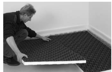
FLOORTEC System-Noppenplatten auslegen.
