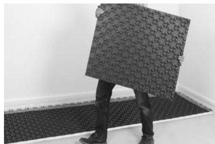
Verlegung von links nach rechts.
