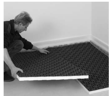
Abb. 1: Verlegung von Systemelementen
