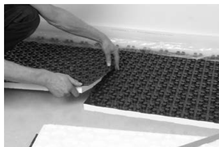
Schnelle und saubere Verlegung durch Überlappungstechnik.
