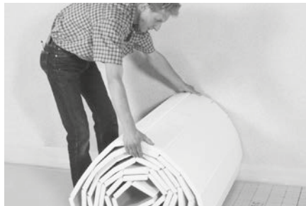
Tackersystemelemente auslegen und ausrollen.
